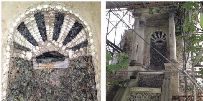
Abb. 115/116 Kaskade mit grottierter Nische an der Taludmauer im Park Sanssouci, Zustand 2014 (Obj. 146)
