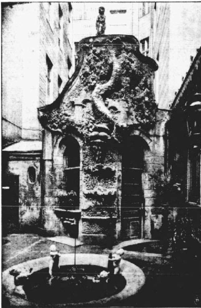
Abb. 77 Gartenhausgrotte Leipziger Straße. Zustand 1910 (Obj. 17)
