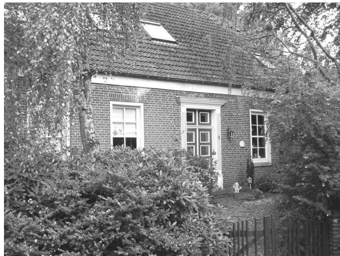
Abbildung 22: Westansicht zur Straße „An der Seefahrtsschule“
