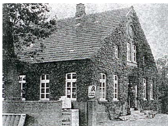
Abb. oben: Giebel zur Ulbarger Straße, Norden.
