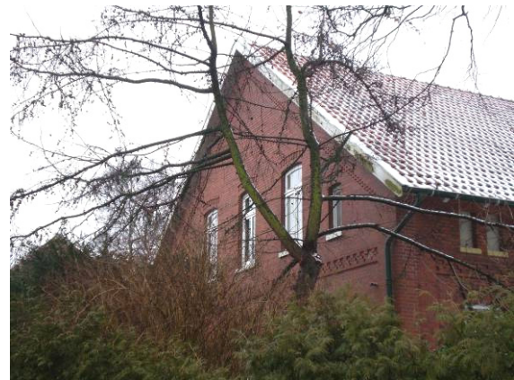
Abb. oben: Die fünfachsige Traufseite zeigt die typischen Segmentbogenfenster und paarweise angeordneten Blindfenster im Drempegelgeschoss.
