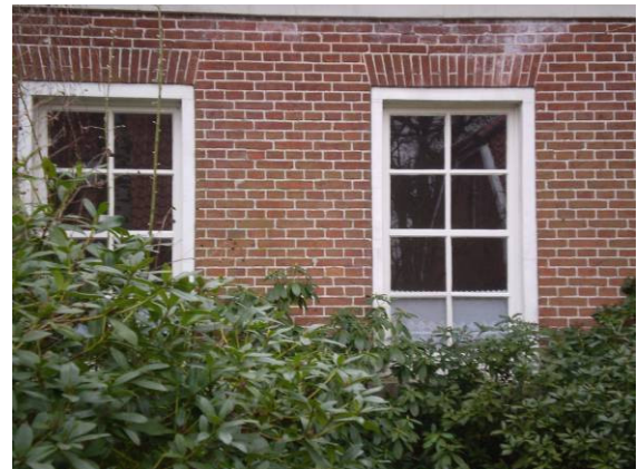
Abb. oben: Nordgiebel, Dachgeschossfenster mit bauzeitlichen Blockrahmen.
