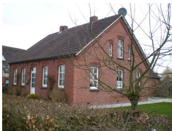
Abb.: Übereckansicht der ehemaligen Schmiede Eggen von Südwesten.
