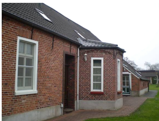
Abb. oben: Übereckansicht von Nordosten.
