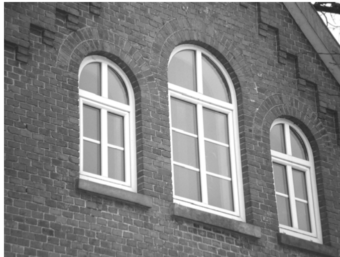
Abbildung 12: Fensteranordnung im Westgiebel und Ausschnitt des Stufengesims
