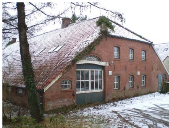
Abb. oben: Übereckansicht von Südosten.
