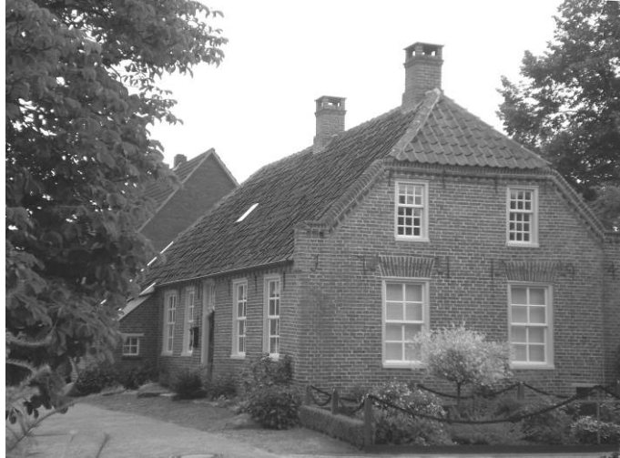
Abbildung 17: Übereckansicht des Vogthuses nach der Instandsetzung 2004-2006
