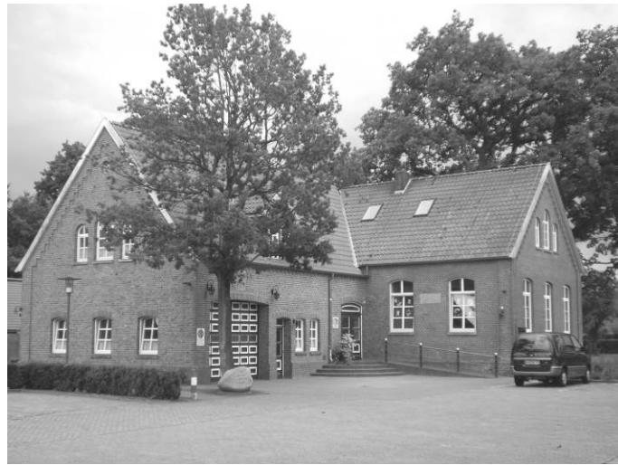
Abbildung 11: Das ehemalige Schulgebäude von 1891 mit einem quergestellten Anbau von 1991
