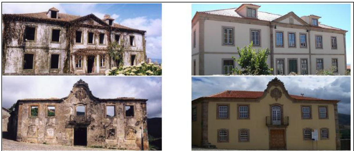
Abbildung 7: Die Herrenhäuser Solar Corte Real (oben) und Casa Brandão de Melo vor und nach der Sanierung, Navega Ferreira, 2011
