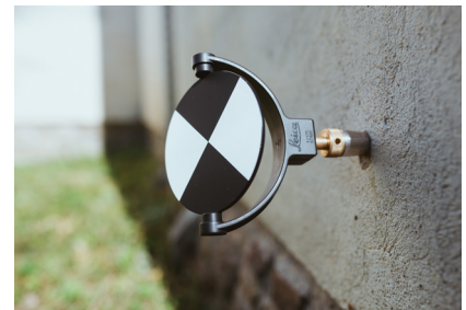
Fig. 2: Messpunkt für den 3D-Scanner Leica P40; die Schachbrettmarke sitzt auf einem Höhenbolzen des Feinnivellements an der Kirchenwand direkt auf - der Kreuzungspunkt der Marke wird durch den Tachymeter angezielt.
