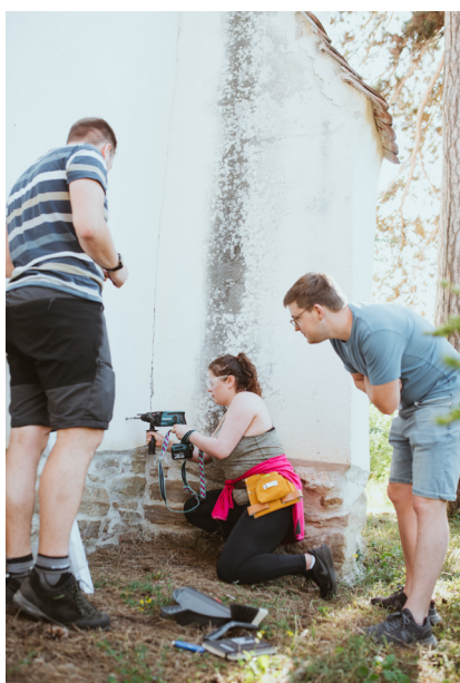
Fig. 4: Bohren der Löcher für die Höhenbolzen
