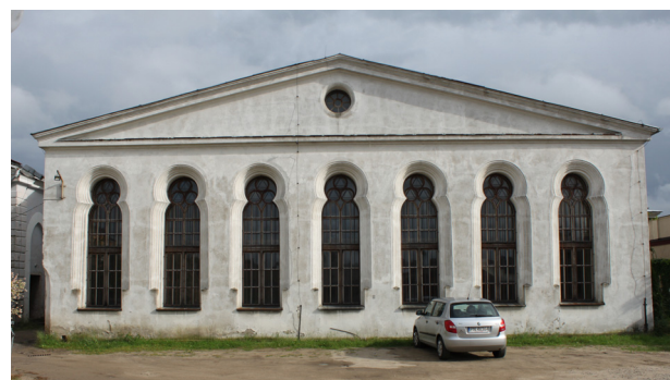
7 Widok synagogi od tylnej strony, część dobudowana w 1875 r.
