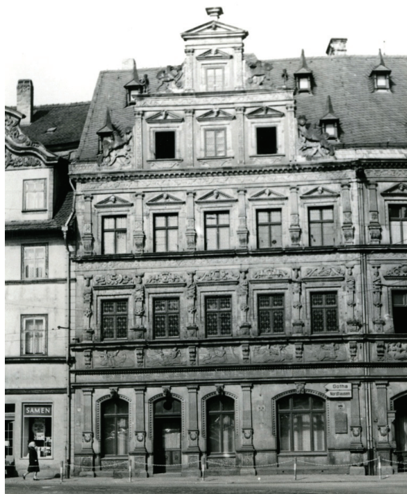
Abbildung 19 Haus zum Breiten Herd, Ansicht von Südosten, 1967
