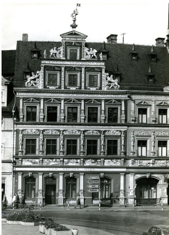
Abbildung 20 Haus zum Breiten Herd, Ansicht von Südosten, 1970
