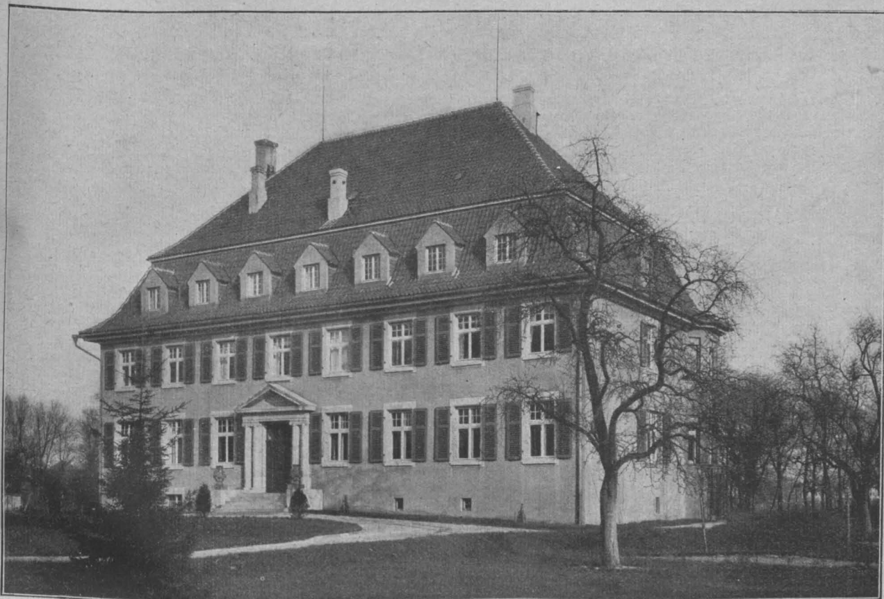
Wohnhaus des Landrates in Burgdorf. Ansicht von Nordwesten.
