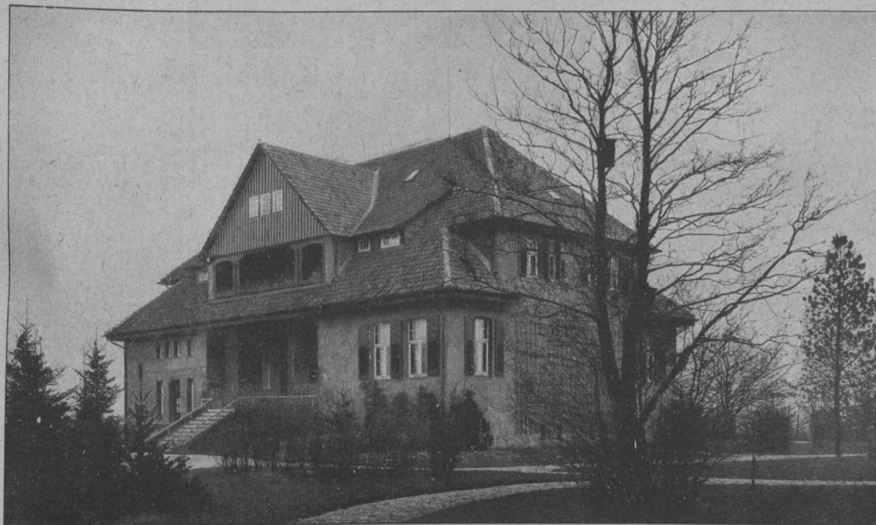
Wohnhaus des Betriebsleiters der Kali-Gewerkschaft Riedel in Hünigsen bei Burgdorf i. H. Nordseite.
