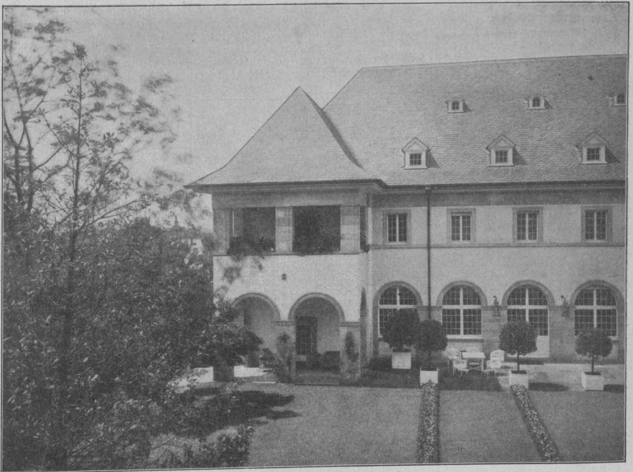
Teilansicht der hinteren Hausfassade.
