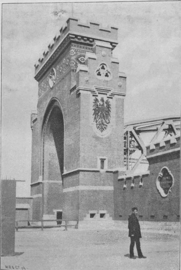
Neue Brücke in Dirschau.
