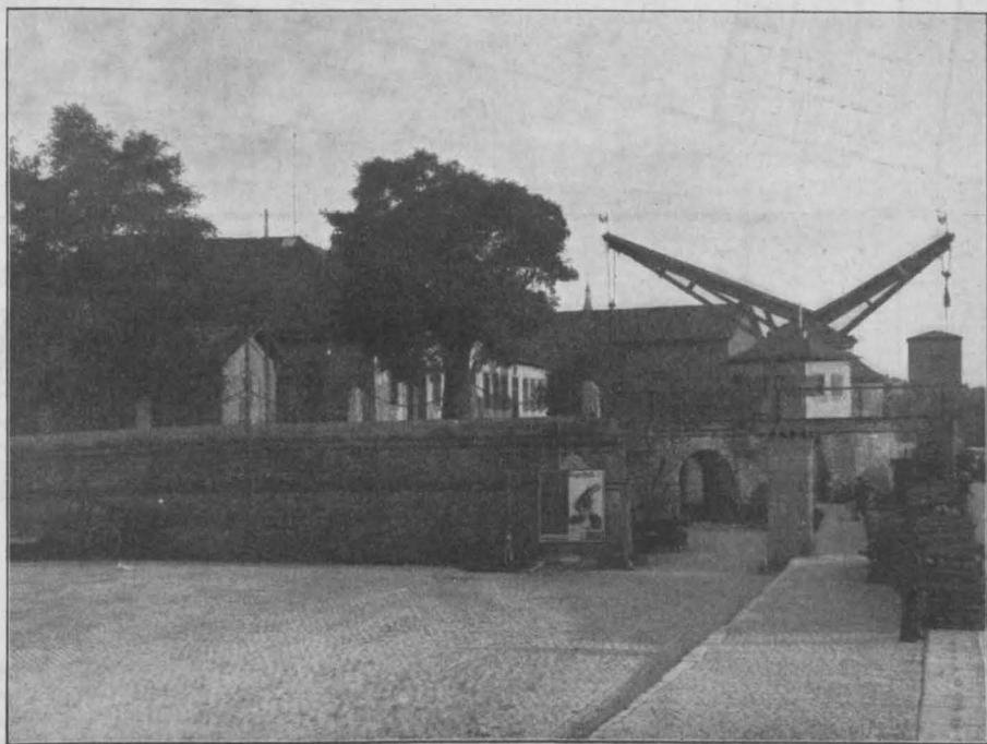
Blick auf das alte Hauptzollamts-Gebäude von Norden her, mit Kran.
