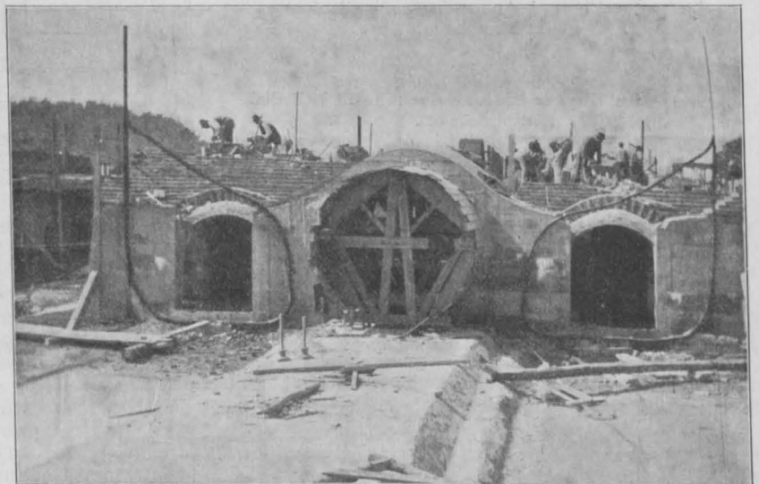
Abbild. 7, 8 und 9. Unterhaupt der Schleuse mit geschlossenem Hubtor von außen gesehen. Desgl. mit offenem Hubtor von innen gesehen (bei der 1. Schleuse). Schleuse während der Ausführung; Trennungsfugen in der Mittelmauer am Oberhaupt.
