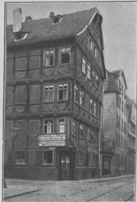
Haus „Eskuche“, Graben.
