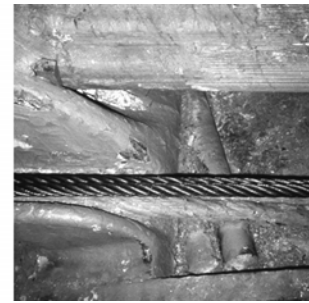
Abb. 92: Brooklyn Bridge; Links: Ansicht, Mitte: Detail des Pylonkopfes [ 556], Rechts: Detail eines Lagersattels, die verkanteten Walzen sind deutlich sichtbar; [ 556]
