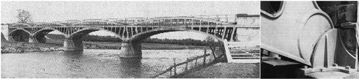
Abb. 5: Dunham-Gelenkbogenbrücke; Links: Ansicht, Rechts: Lagerdetail [ 195]
