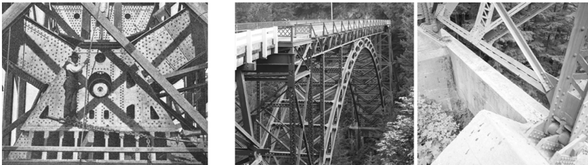
Abb. 100: Links: Auflager der Québec-Brücke [ 137]; Mitte/Rechts: Fairfax-Brücke; Ansicht/Auflagerdetail [ 691/ Foto: Jet Lowe]
