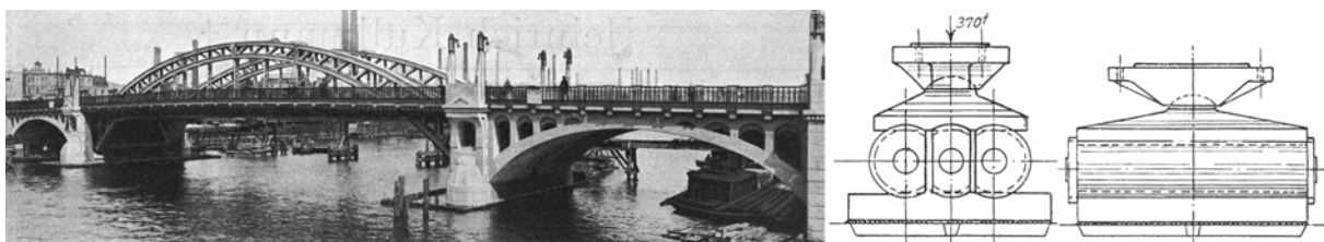
Abb. 18: Stubenrauchbrücke Berlin; Links: Ansicht [ 123], Rechts: Lagerdetail [ 126]
