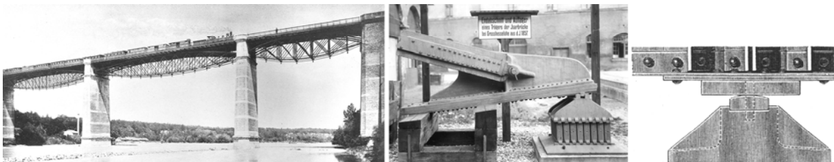
Abb. 15: Isarbrücke Großhesselohe; Links: Ansicht [ 676], Mitte: Nach dem Abriss der Brücke gesicherte Auflagereinheit [ 678], Rechts: Prinzip der Berührungs-Kipplager: In der Berührungsfläche des Kippteils wälzen unterschiedlich gekrümmte Flächen aufeinander ab [ 108]
