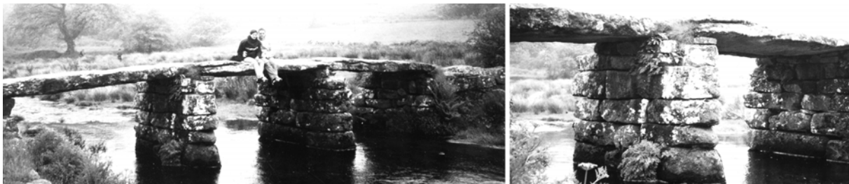
Abb. 91: Clapper Bridge in Postbridge, Süd-West-England; Links: Ansicht, Rechts: Mittelpfeiler; [ 670]
