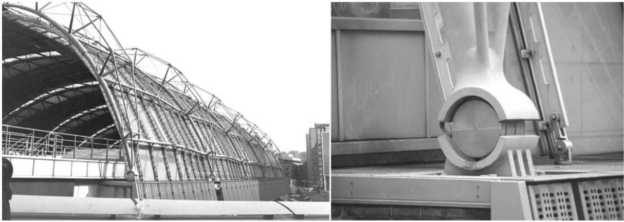
Abb. 50: Waterloo International Station; Links: Ansicht, Rechts: Auflagerdetail [ 670]
