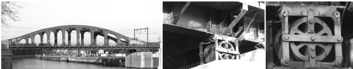
Abb. 82: Pont de Laeken in Brüssel, 1942; Links: Ansicht, Mitte und Rechts: Lagerdetail [ 670]
