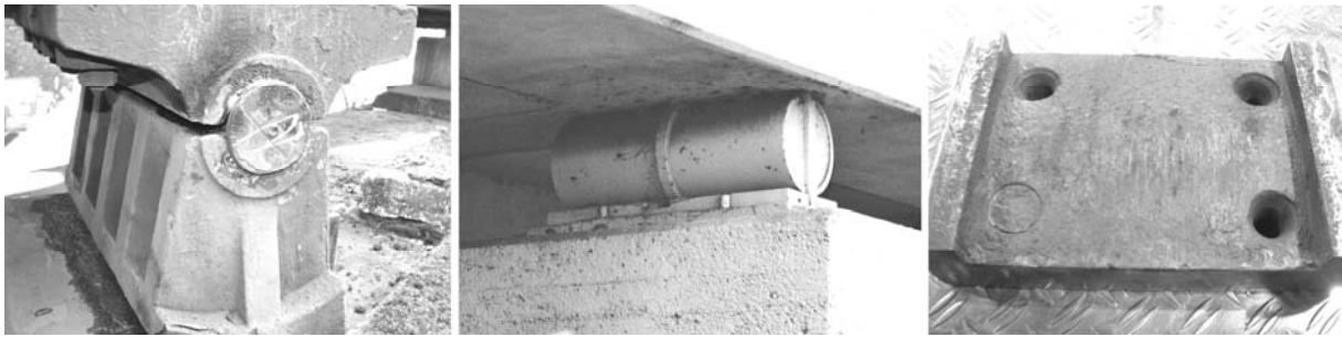
Abb. 70: Beispiele für Lager mit verknüpfter Translations- und Rotationsvorrichtung; Links: Zylinderzapfen-Pendellager der Wasserturmbrücke Berlin-Ostkreuz, Mitte: Einrollenlager der Erfthbrücke in Neuss/Rhein, Rechts: Linienkipp-Gleitlager der Hochbahnlinie U2 Berlin nach dem Ausbau und Reinigung; An der gewölbten Kippplatte sind deutlich die Spuren des Gleitens zu erkennen. Die Art der Befestigung des Lagers am Tragwerk veranschaulichen sowohl die Bohrungen als auch der verbliebene Senkniet; [ 670]
