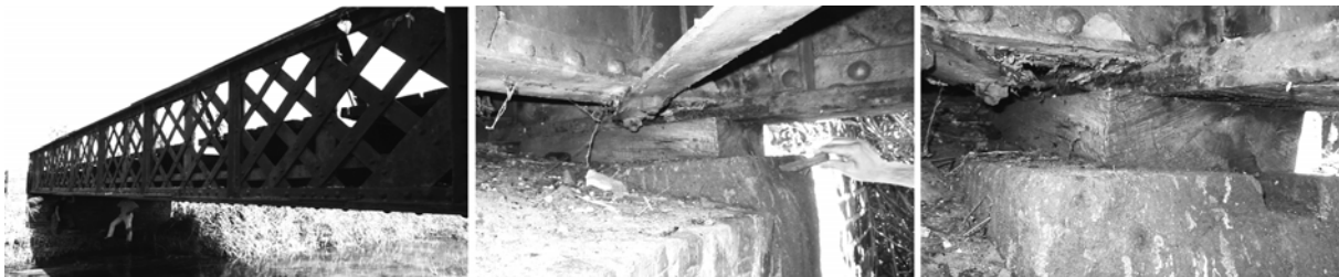
Abb. 7: Malxebrücke Peitz-Luisenruh; Links: Ansicht, Mitte/Rechts: Hölzernes Auflager; [ 670]
