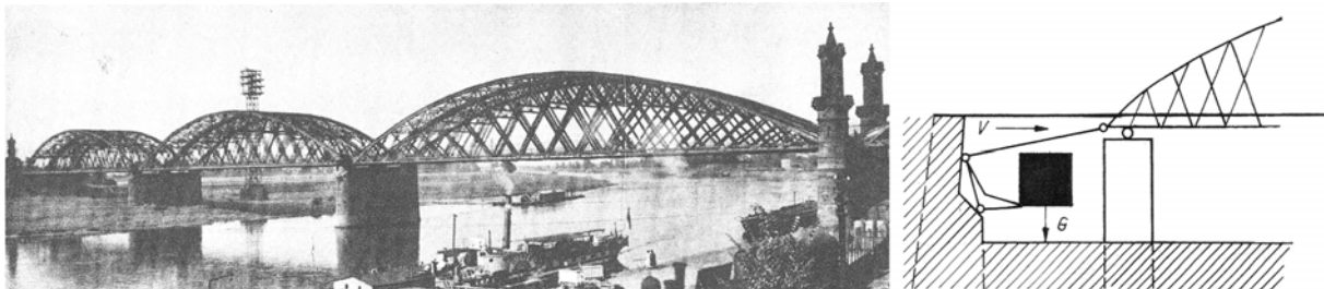
Abb. 60: Elbebrücke Riesa; Links: Ansicht [ 560], Rechts: Vorspannmechanismus [ 548]
