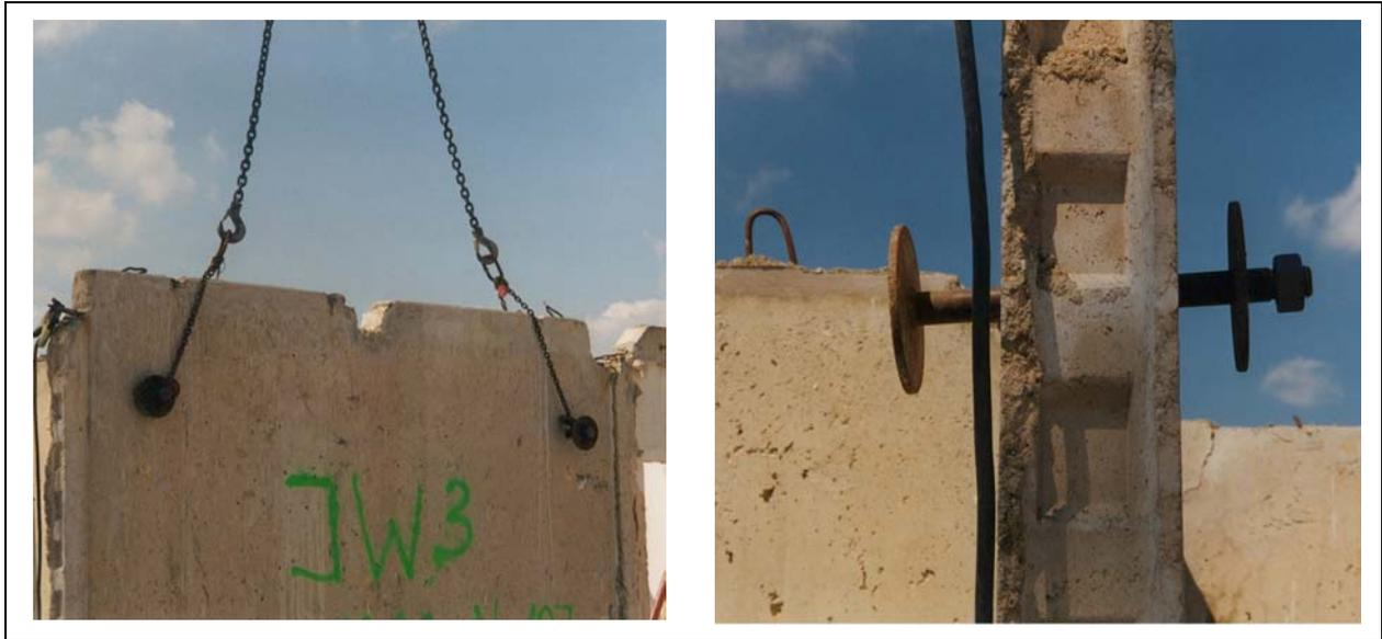
Abb. 4.4: System Tragbolzen mit Gehänge bei der Demontage
