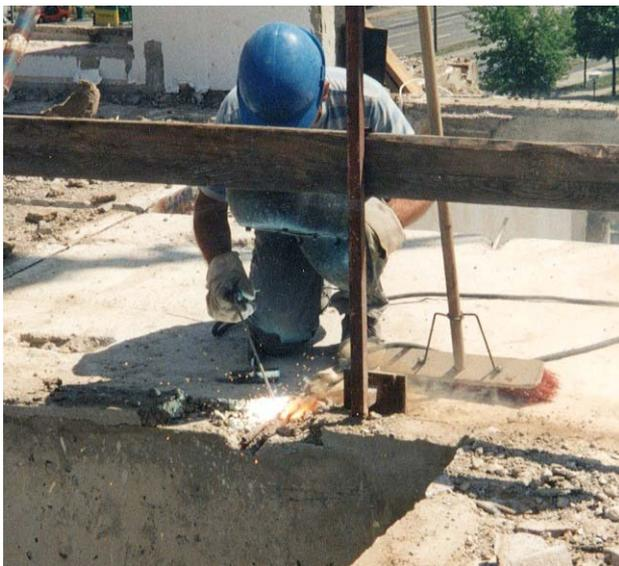
Trennen einer Schweißverbindung (Lichtbogen-Schmelzscheiden)
