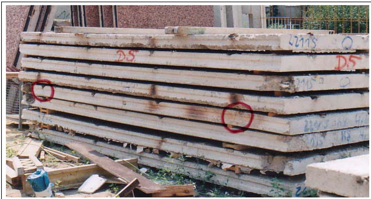
Abb. 5.4: Falsche Anordnung der Stapelhölzer bei der Zwischenlagerung von Deckenelementen
