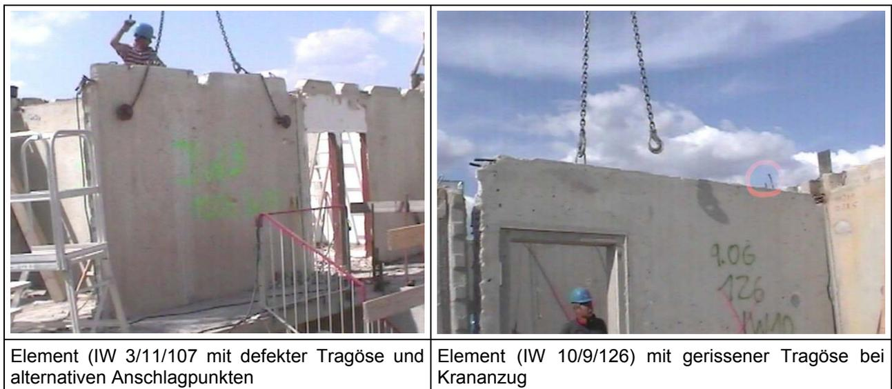
Abb. 7.7: Defekte *Tragösen* und alternative Anschlagpunkte bei Innenwänden
