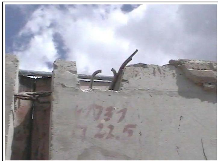
Abb. 7.14: Element AW 1/9/127: Bruch der Tragöse bei der Demontage
