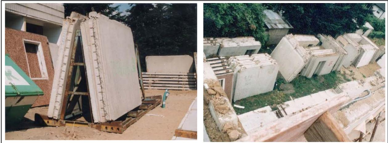
Abb. 5.6: Lagerung von Wandelementen an A-Böcken und Deckenstapeln
