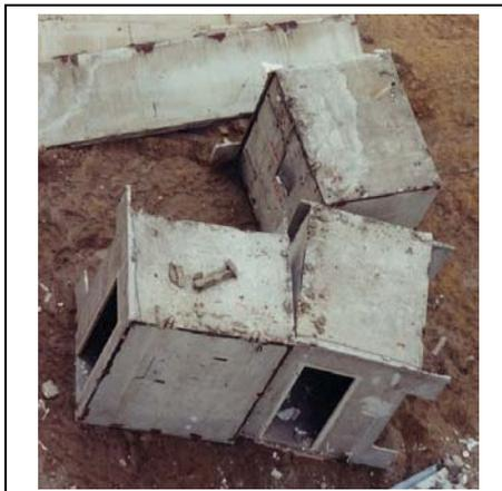
Abb. 7.15: Lagerung demontierter Sanitärzellen
