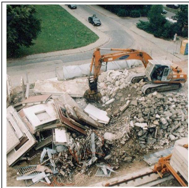
Abb. 5.3: Variante 1: Vorbrechen vor Ort mit 30 t - Bagger
