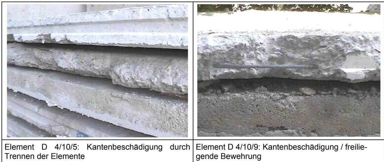
Abb. 7.9: Kantenbeschädigungen an Deckenelementen
