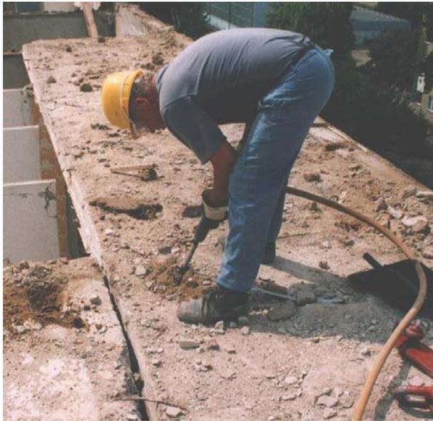
Freilegen einer Deckentragöse mit Druckluft-Abbruchhammer
