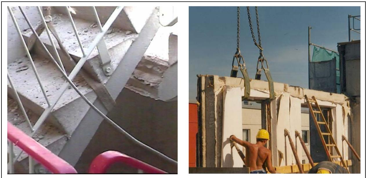
Abb. 4.5: Einsatz von Hebebändern bei der Demontage
