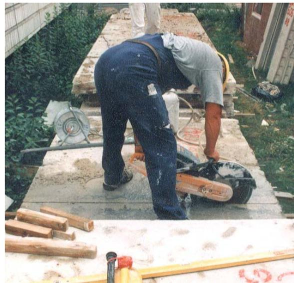
Kürzen eines demontierten Deckenelementes mit handgeführtem Fugenschneider
