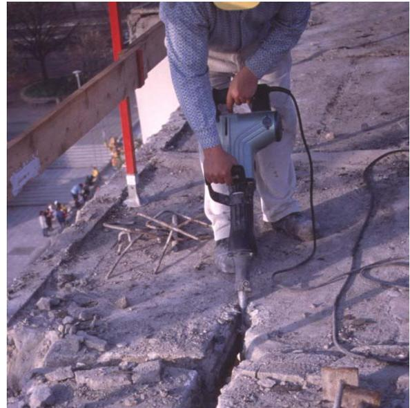
Aufstemmen einer Fuge zwischen zwei Deckenplatten mit Elektro-Abbruchhammer
