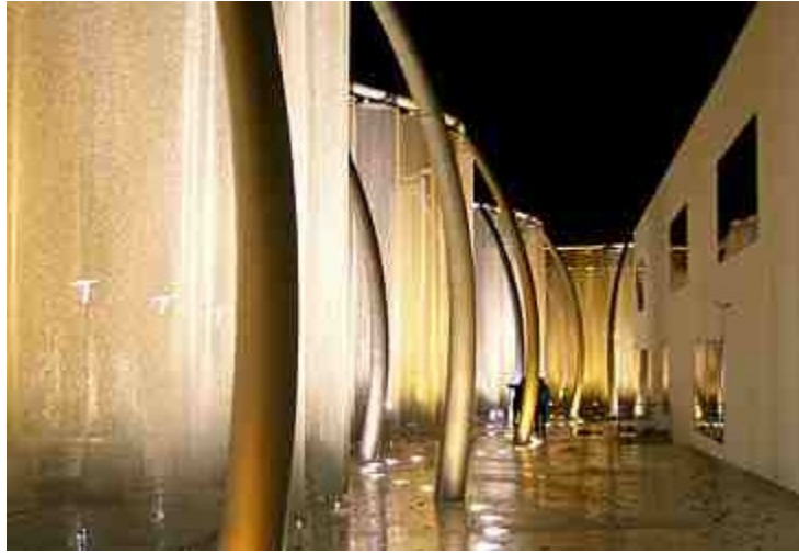
Abb. 1-5 Gestaltung der Außenfassade der Swarovski AG in Wattens (Österreich) unter Verwendung von Edelstahlringgeflecht (Quelle: Friedrich Münch GmbH)
