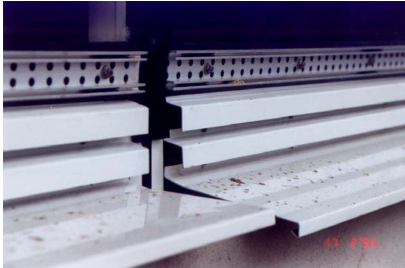
Abb. 7: Fußpunkt Doppelfassade vor Einbau der PV-Module.
