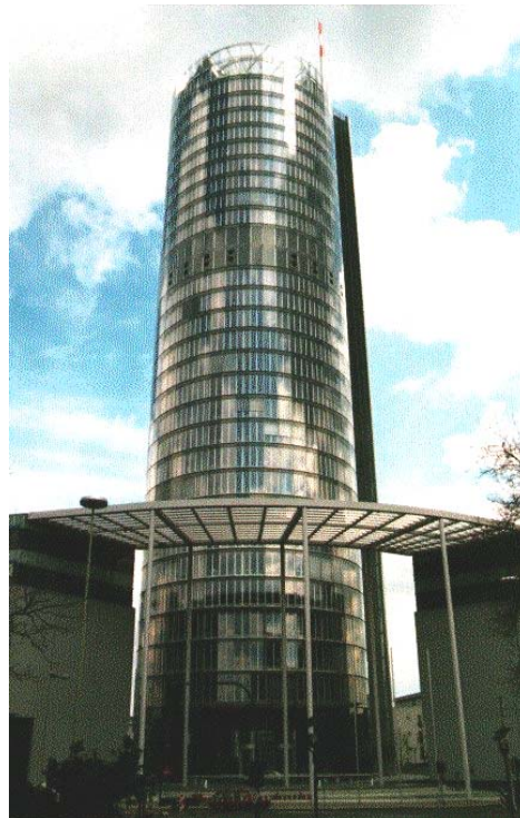
Abb. 2: Ansicht einer Doppelfassade (RWE-Tower in Essen).
