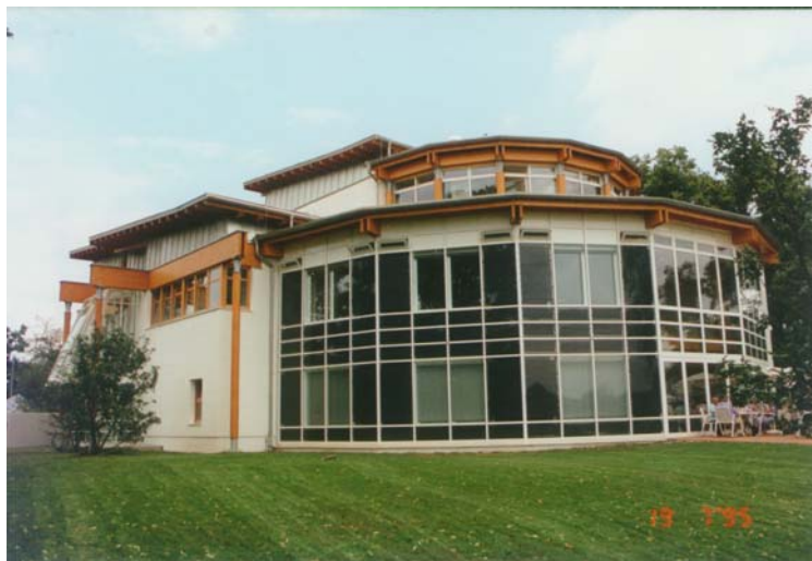
Abb. 5: Süd-Westansicht des Umweltzentrums Cottbus.
