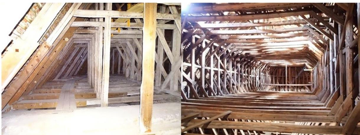
Abbildung 157: Dachkonstruktion über dem Hauptschiff/Langhaus (Bildquelle links: Mühlisch, 2019; Bildquelle rechts: [Seemann, 2018])
