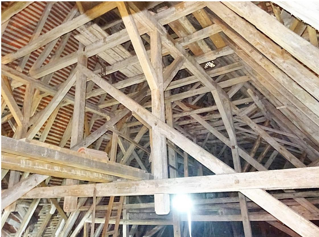
**Abbildung 3: Teil der Dachkonstruktion der „Wunderblutkirche“ St. Nikolai, Bad Wilsnack/Brandenburg, erbaut ca. 1520 (Bildquelle: Linke, 2018)**
