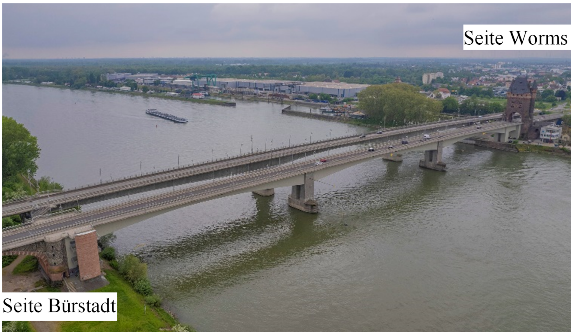
Abb. 1: Gesamtansicht der Nibelungenbrücke (in Richtung)
