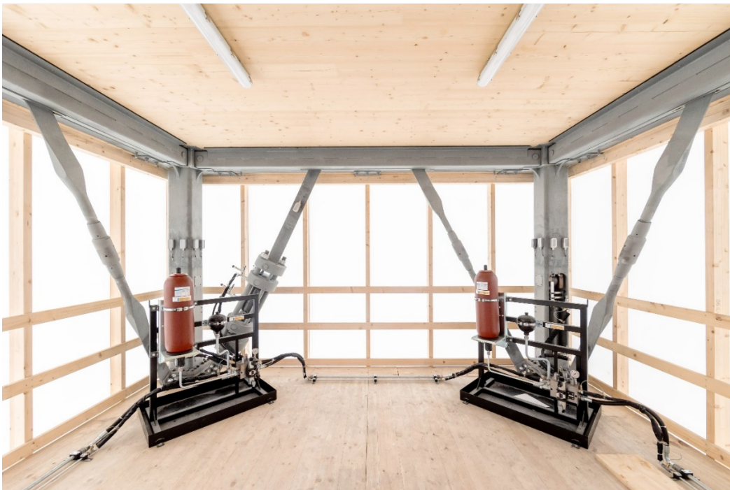
Abb. 2: D1244: technischen Komponenten zur Aktuierung von Stützen und Aussteifungen (© Uli Regenscheit)
