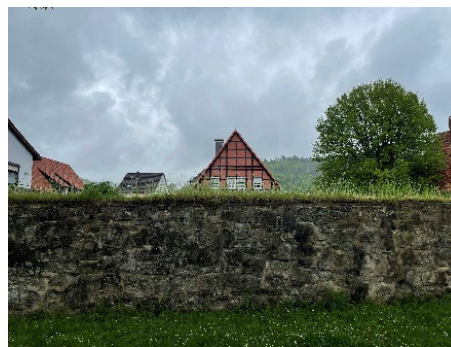
Abb. 68: Stadtmauer als Hochwasserschutz in Lügde (cK)
