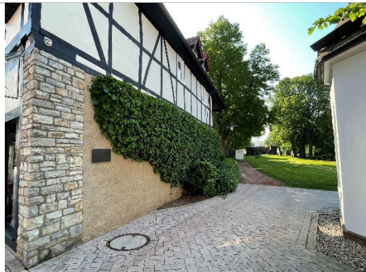
Abb. 42: Fassadenbegrüpfung am Fachwerkhaus (cK)
