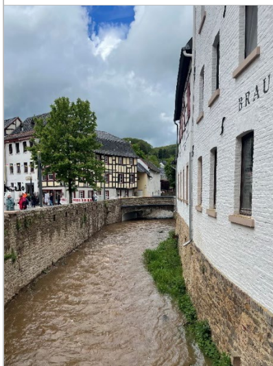
Abb. 30: Kanalisierte Erft im Stadtkern – Löcher in der Mauer lassen Wasser von der Straße abfließen (cK)
