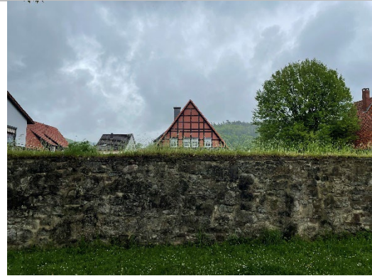
Abb. 52: Stadtmauer als Hochwasserschutz(cK)
