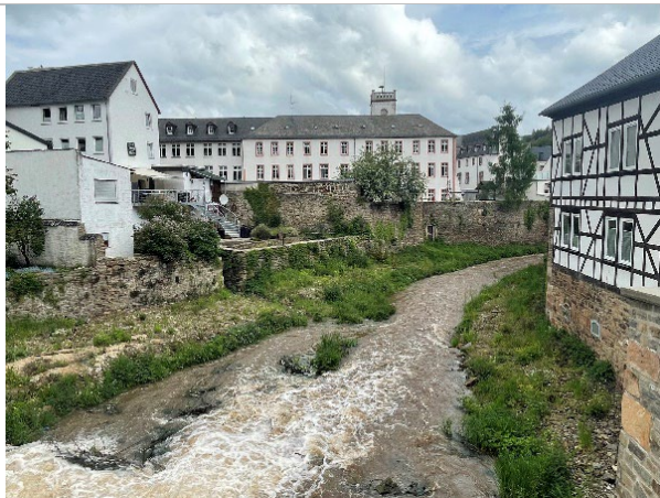
Abb. 33: Erft mit Retentionsraum (cK)
