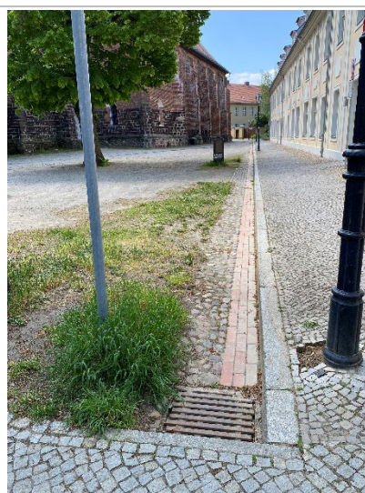
Abb. 46: Kirchplatz Regenwasserabfluss (cK)
