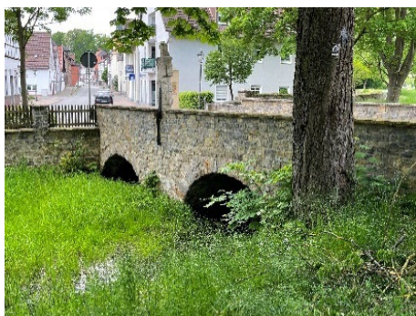
Abb. 67: Retentionsraum im Stadtgraben in Brakel (cK)
