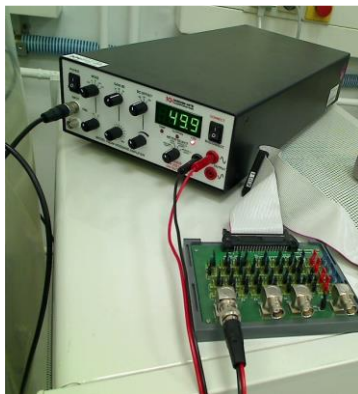
Verstärker mit der Switch-Matrix zur Ansteuerung einzelner Kontakte
