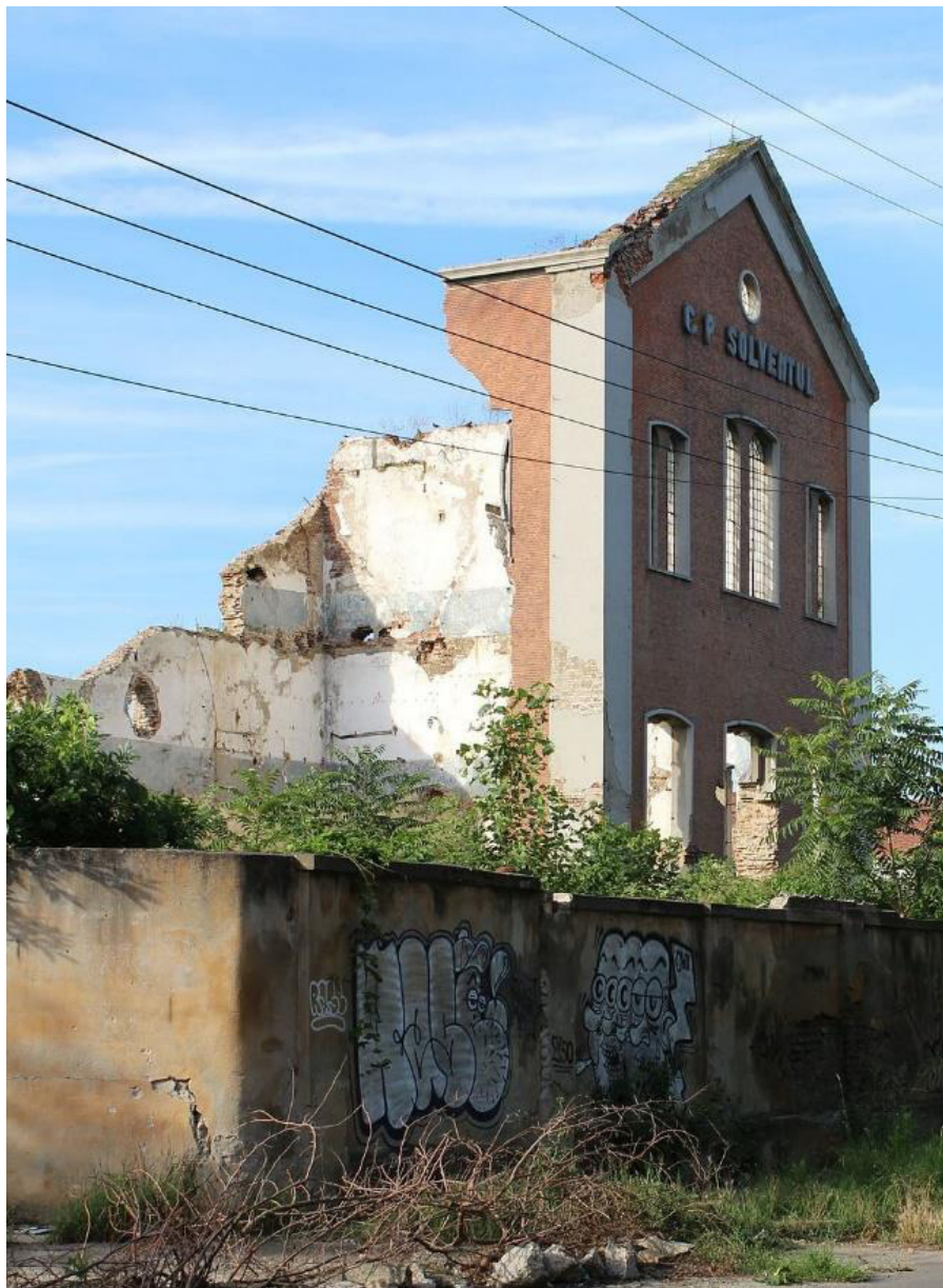
Abb. 1: Solventul Petrochemikalienfabrik (Turbojet 2016)
