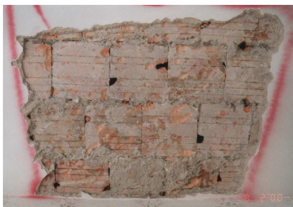
Abb. 10-6: Steineisendecke ohne Mörtel in den Stoßfugen
