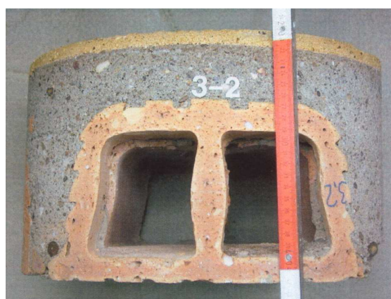
Abb. 10-7: Versatz der Ziegelwandungen aufgrund ungleichmäßiger Ziegelabmessungen
