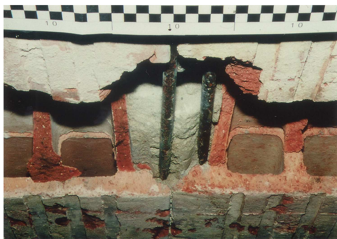
Abb. 10-2: auf der Sohlleiste aufliegende Bewehrung
