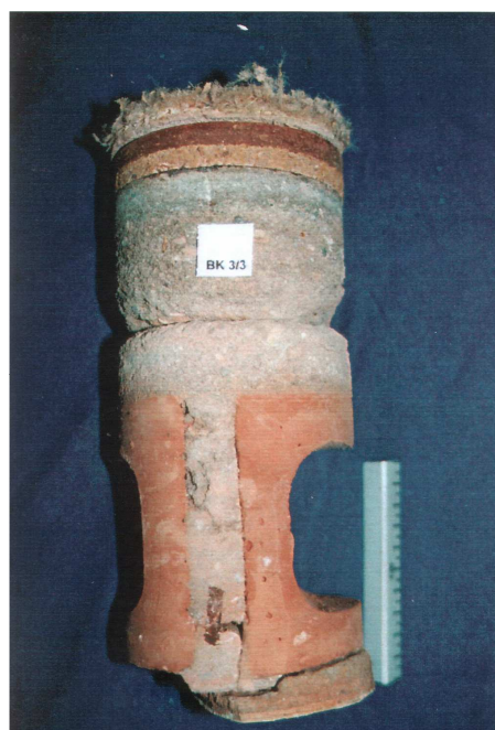
Abb. 10-10: Fehlstellen innerhalb einer Längsfuge
