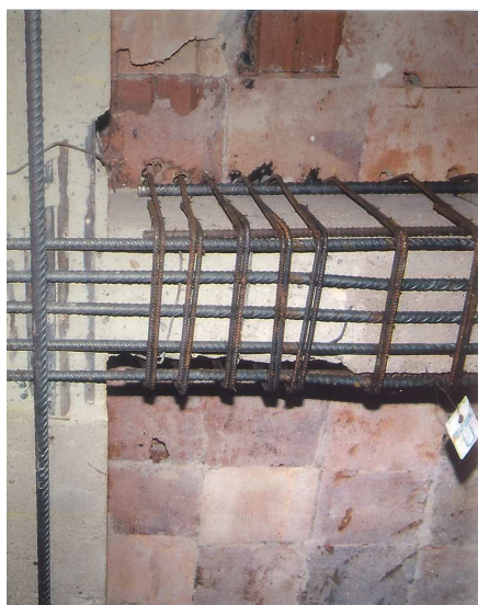
Abb. 10-14: Reformhohlsteindecke ohne Stoßfugenversatz
