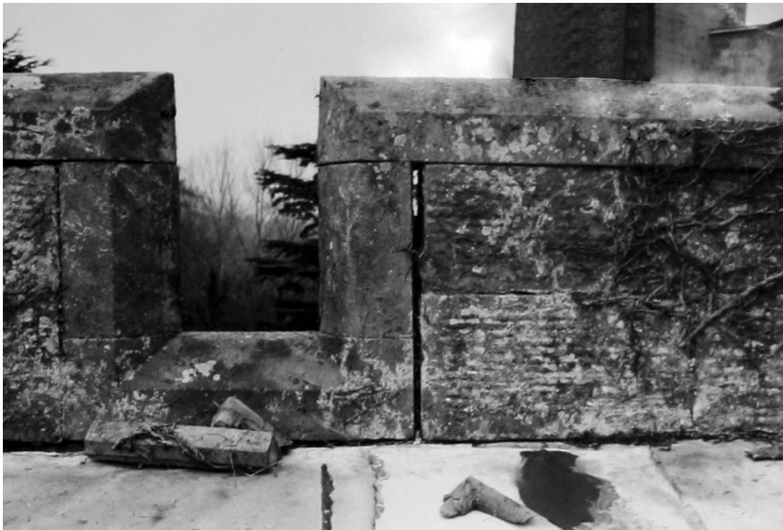
Abb. 69: unbek., Eastnor Castle, Phase III, Zustand der Brüstungsmauer auf der Entrance Hall vor der Restaurierung , 1989, digital überarbeitet von J. Berger, 2020.
