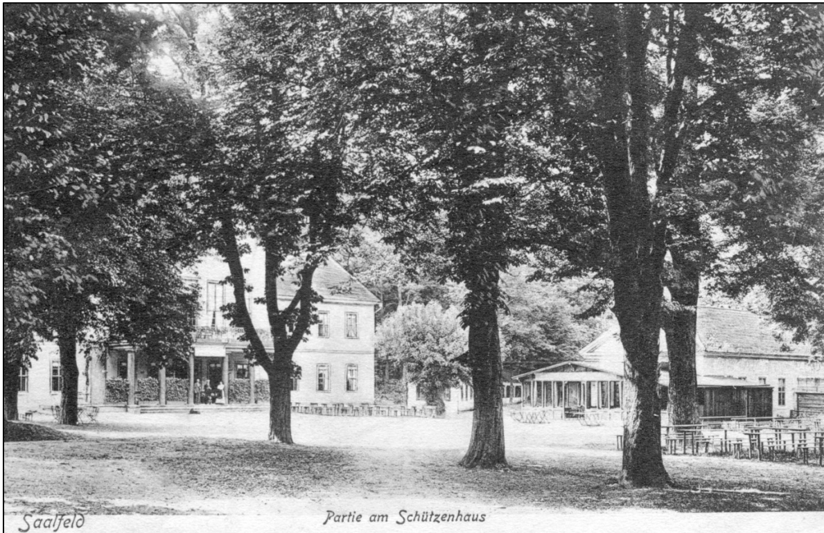
Saalfeld, Schützenhof, Ansicht von Südosten, nach 1902
