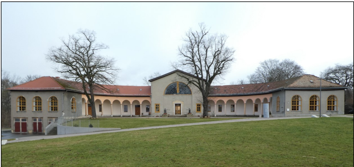
Weimar, Schießhaus, Ansicht von Südwesten, 2021
