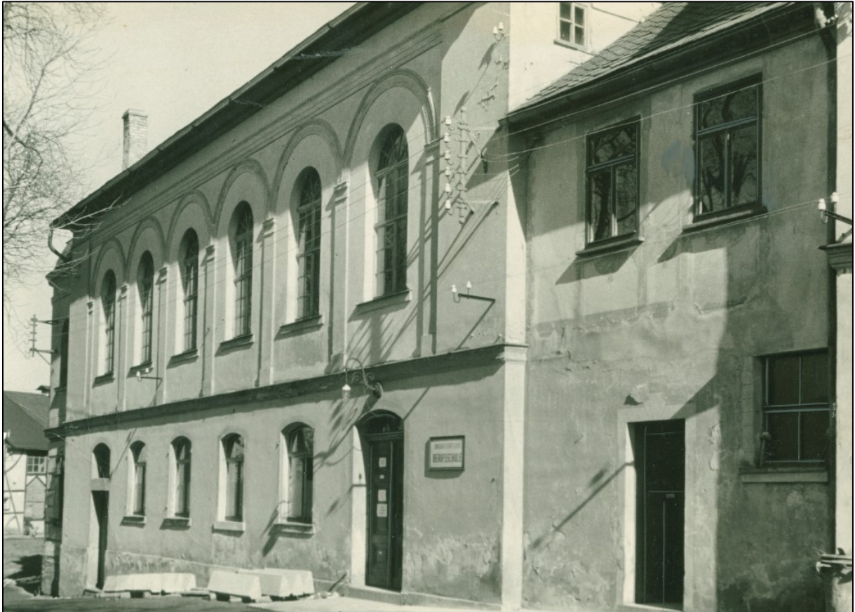
Zeulenroda, ehem. Schützenhaus, Ansicht von Südwesten, 1960 – 1969
