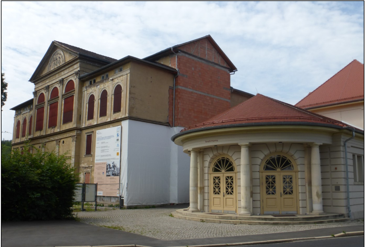
Meiningen, Schützenhaus (links) und Eingangsbereich des Schützenhaussaals, Ansicht von Nordosten, 2021
