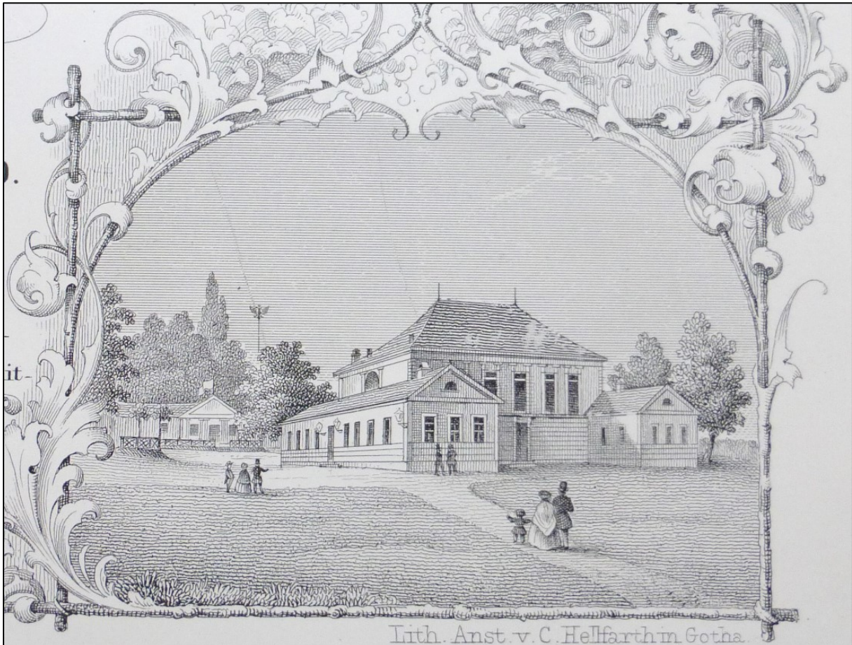
Gotha, Schützenhaus, Ansicht von Südosten 1860
