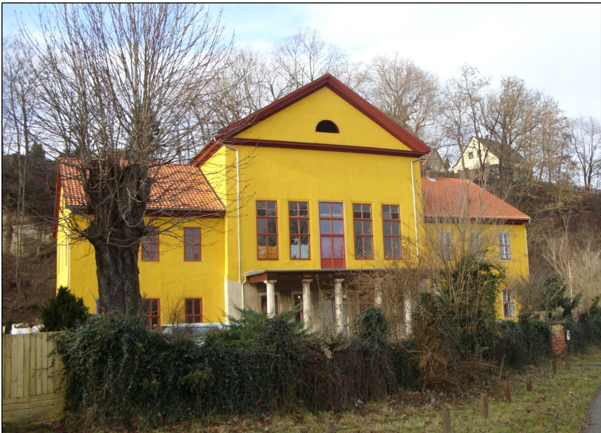
Saalfeld, Schützenhaus, Ansicht von Osten, 2019
