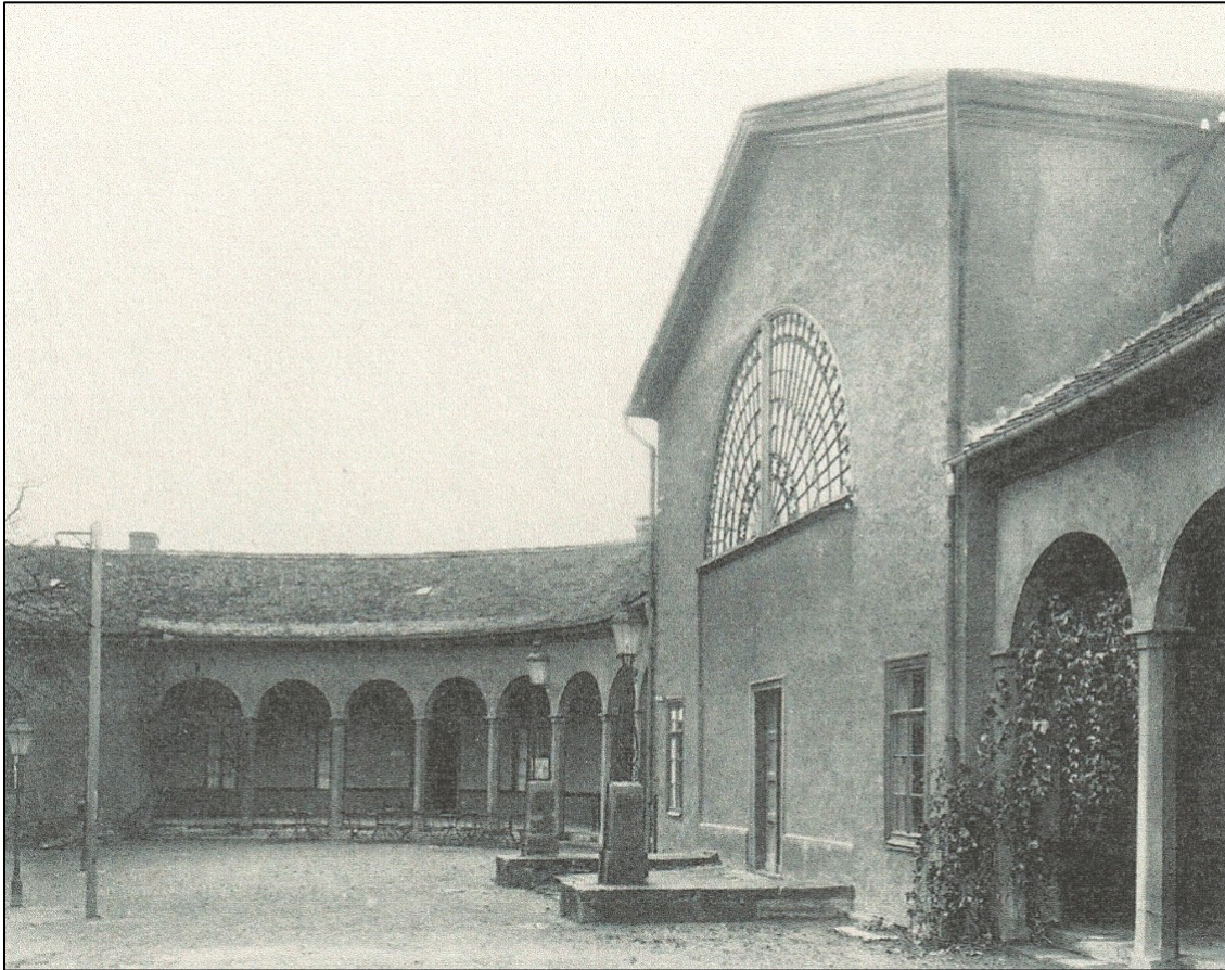
Weimar, Schützenhaus der Büchschützengesellschaft, Ansicht von Süden, 1916
