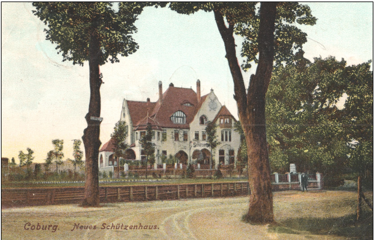
Coburg, Neues Schützenhaus (1904), 1907
