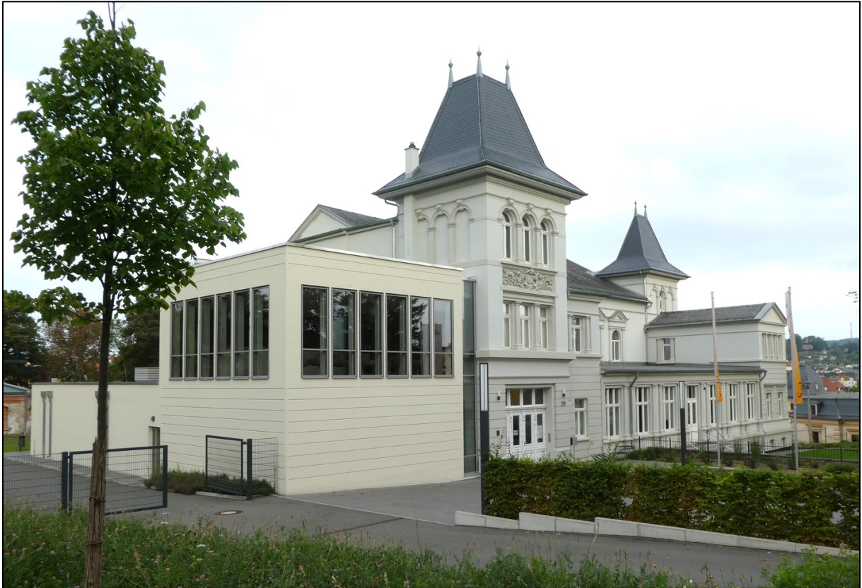
Pößneck, Schützenhaus, Ansicht von Osten, 2021
