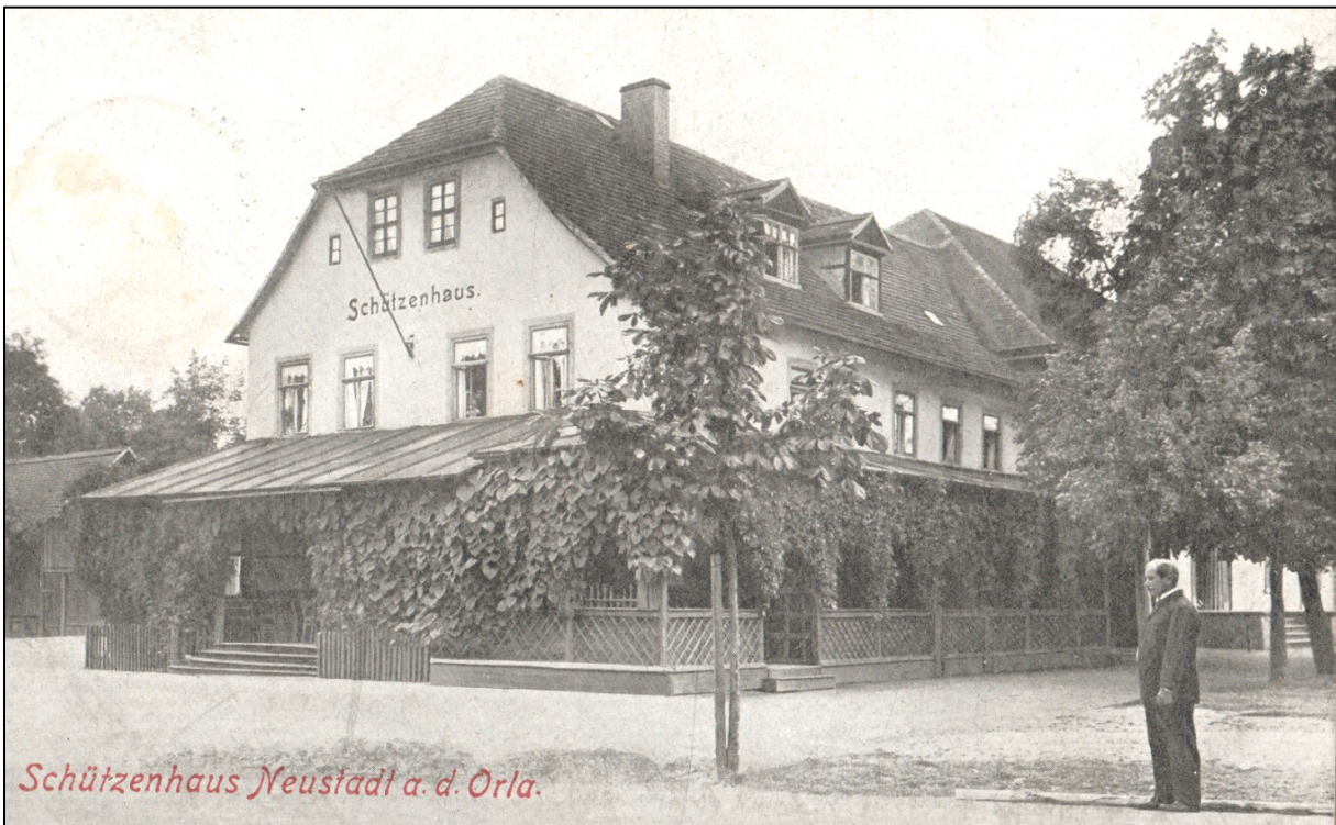
Neustadt an der Orla, Schützenhaus, Ansicht von Südosten, um 1920
