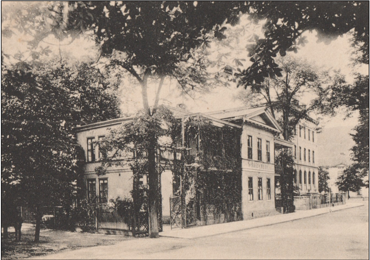
Rudolstadt, Schützenhaus, Ansicht von Südosten, um 1900
