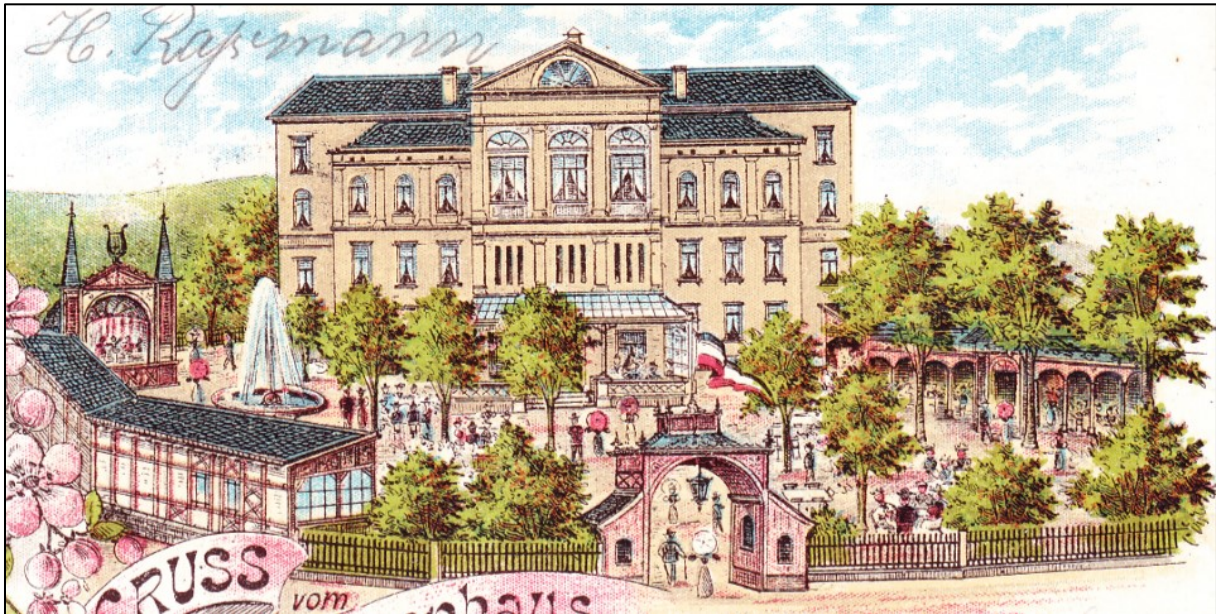
Meiningen, Schützenhof, Ansicht von Osten, 1899
