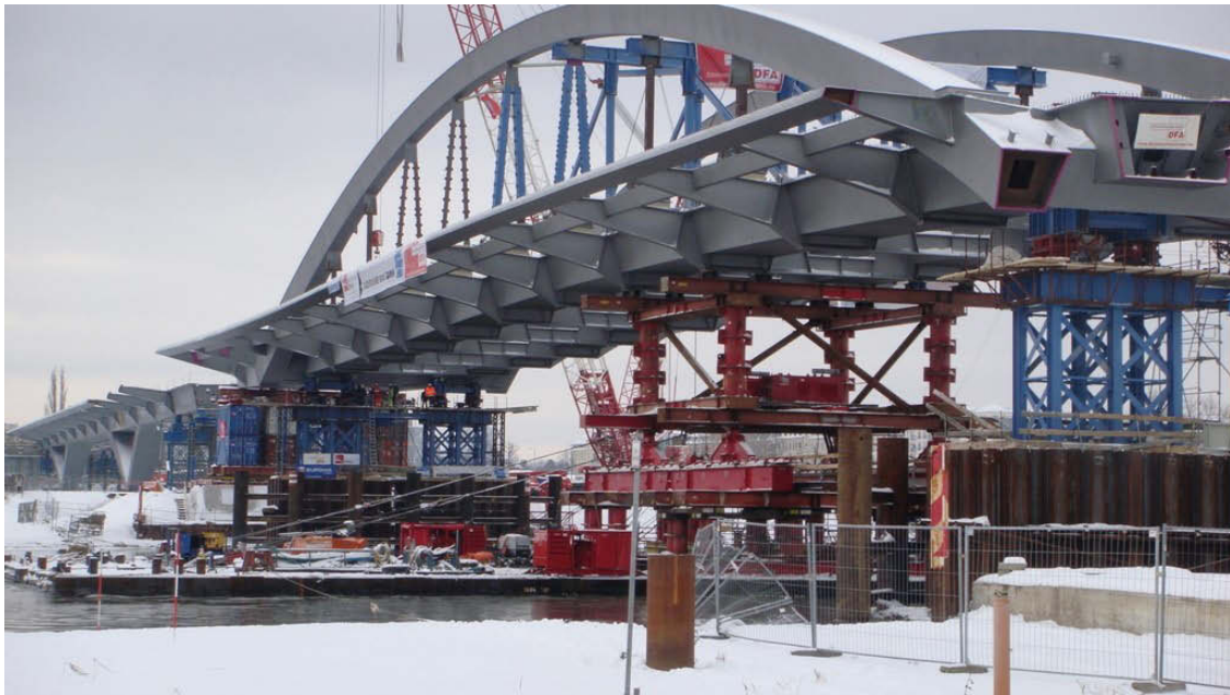
Abb. 1-17: Einschwimmen des Bogenträgers der Waldschlösschenbrücke in Dresden
