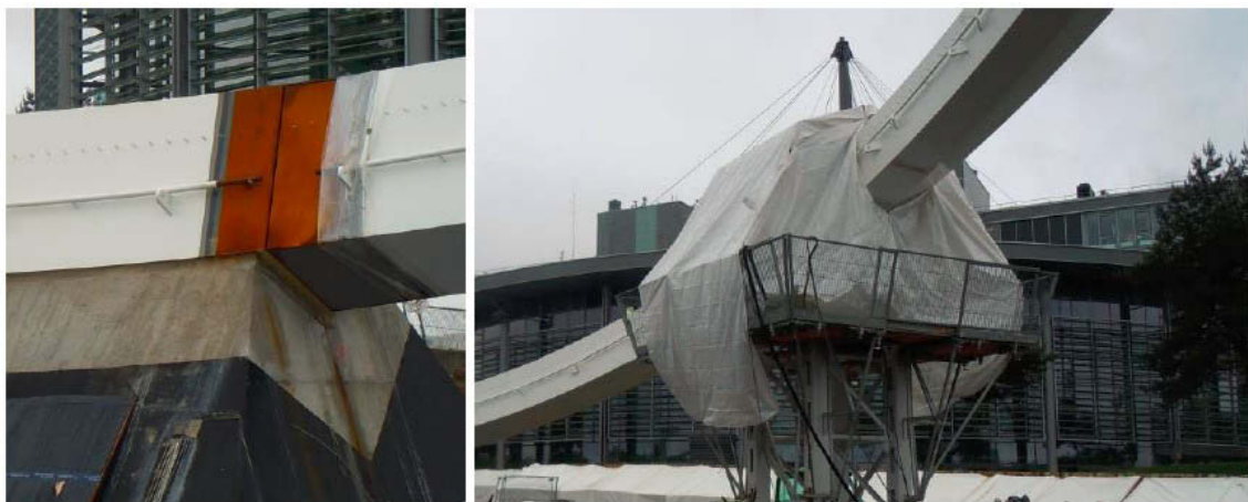
Abb. 1-16: Montage auf der Baustelle und Einhausung der Schweißstelle, AKC in der Autostadt Wolfsburg
