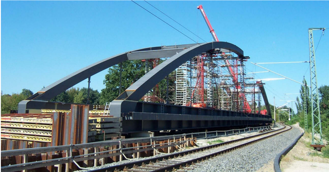
Abb. 1-15: Montage einer Brücke in Eisenhüttenstadt [Füg-07]
