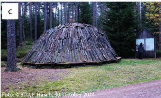
Abbildung 10: Aufbau und Betrieb eines Holzkohlemeilers: Konstruktion des Meilers.
