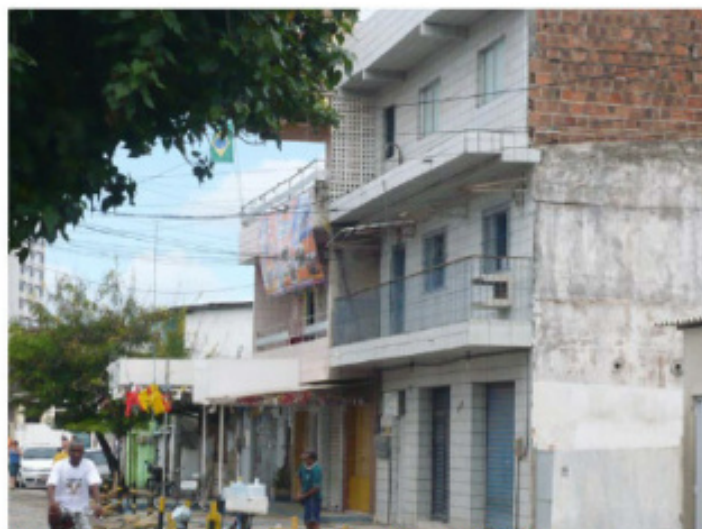
Pina - dreigeschossiges Gebäude, verfließt
