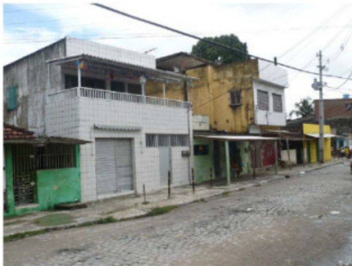
Pina - mehrgeschossige Gebäude, verfließte Fassade
