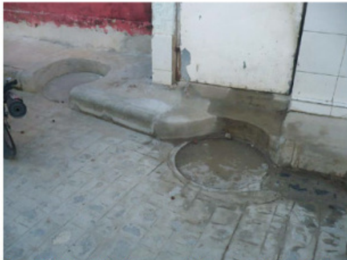
Neue Straßenbefestigung und Umgang mit dem Bestand
