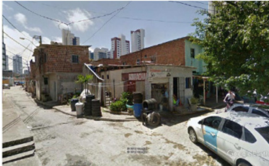
Zufahrt von Südwesten
