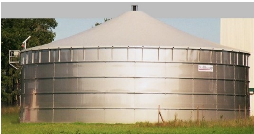
(a) Ausgeführter Glattmanteltank mit gasdichtem Membrandach
