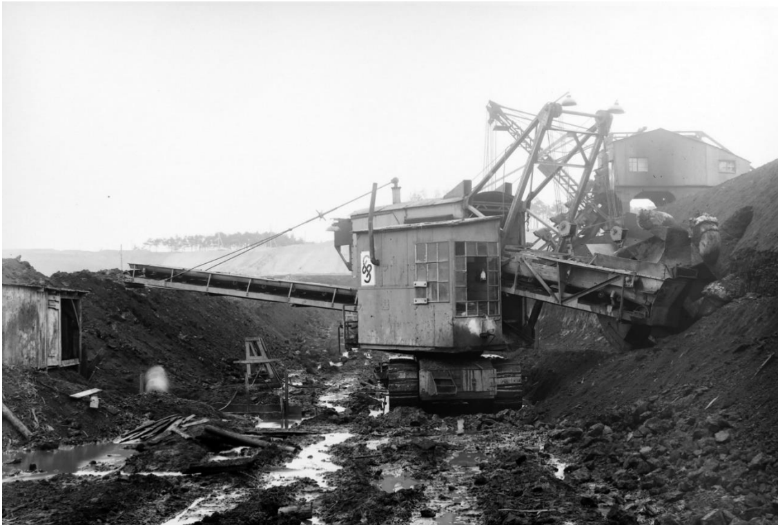
Abbildung 1: Schaufelradbagger aus der Grube Waidmannsheil, 1930 [4]
