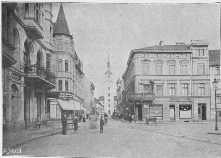
Blick vom Berliner Platz auf die Cottbuserstraße.
