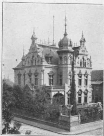
Baugeschäft Bodo Hammer.
