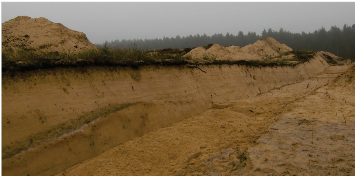
Abb. 4-47 Durch Wind erodierte und überwehte Podsol-Braunerde im Tgb. Welzow-Süd Die an einer Hanglage deutlich ausgebildete Podsol-Braunerde (li. Im Bild) ist im ehemaligen Kuppenbereich durch äolische Erosion gekappt und anschließend von etwa 1,5 m Flugsand überdeckt worden. (Foto: Nicolay 2012)
