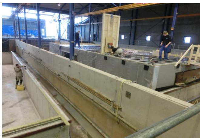
Bild 2 Fertigungslinie für Pontons aus WU – Beton in den Niederlanden, Fa. Arkenbouw
