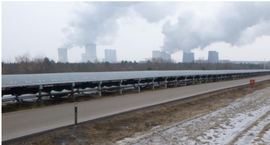
Abb. 1 - Überdachter Gurtförderer für den Transport von Rohkohle ins Kraftwerk
