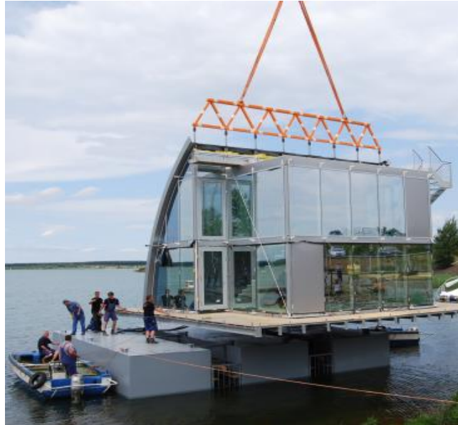
Bild 1 Einschwimmen von Stahlpontons für schwimmende Häuser vom Typ "Ar-che" am Geierswalder See im Lausitzer Seen Land,
