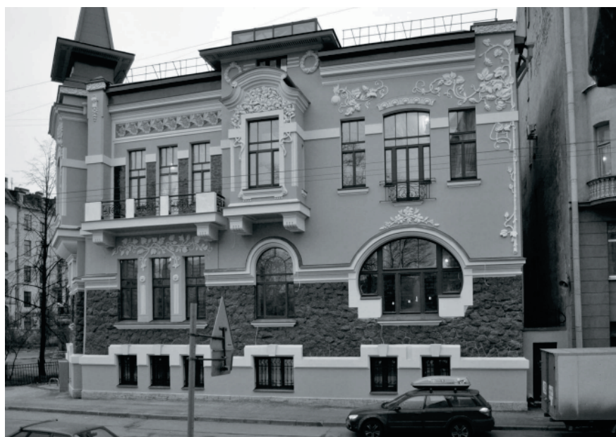
Frisch sanierte Fassade November 2009 Budnitskaya
