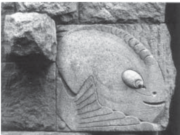
Architekt A. F. Bubir, eigenes Mietshaus in der Stremiannaja Str. 11, 1906-1907 Detail des Eingangsportals Das Haus stellt ein Beispiel neuen Umgangs mit den Verkleidungsmaterialien dar in: Kirikov, 2008, S. 398
