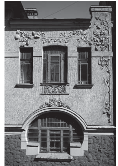
Detail der Hauptfassade Fenster mit historischen Rahmen und Sprossen Die Fassade mit Rauputz, 1907 Hausbesitzerarchiv
