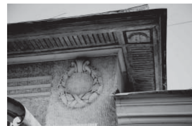
Attika und Dachüberstand des mittleren Teils der Hauptfassade 2008 Hausbesitzerarchiv
