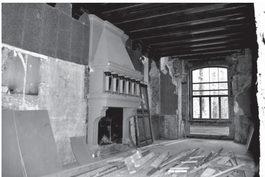
Fragment der Senkkastenbalkendecke
