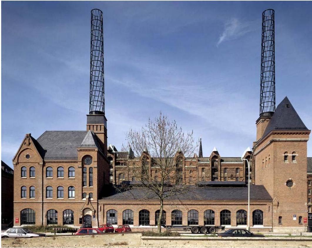
Fig. 25. ©Klaus Frahm, 2001. Kesselhaus, Hamburg . Source: gmp (gmp, 2001)
