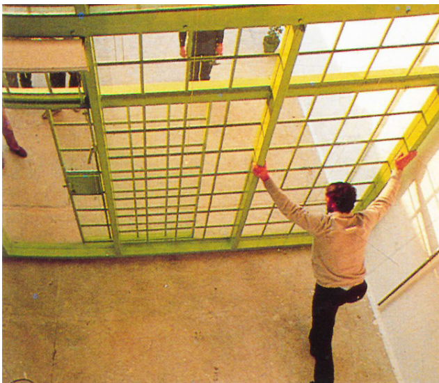
Abb. 2.2.3-1 und Abb. 2.2.3-2 Casa Evolutiva, Renzo Piano 47 . Die in der Nähe von Perugia gebauten Wohnhäuser sind ein perfektes Beispiel der internen Variabilität: dank mobilen, verglasten Außenwänden und einer internen Raumhöhe von 6 m kann der Wohnraum beliebig erweitert oder verkleinert werden; sogar der Einbau einer zweiten Etage ist möglich.
