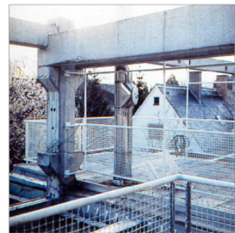
Abb. 6.1.66 Blick über die Dach- terrassen
