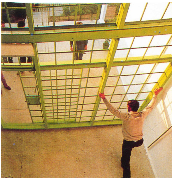
Abb. 4.4.5-7 und Abb. 4.4.5-8 Die Fensterrahmen sind beweglich und auf Schiene gelagert, somit können sie ohne großen Kraftaufwand verschoben werden. Mittels einer leichten Geschossdecke lässt sich eine mittige Unterteilung des Raumes vornehmen.
