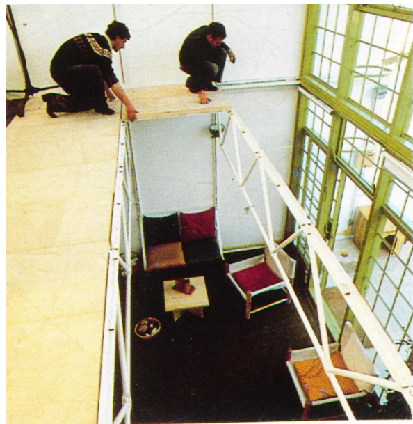
Abb. 4.4.5-7 und Abb. 4.4.5-8 Die Fensterrahmen sind beweglich und auf Schiene gelagert, somit können sie ohne großen Kraftaufwand verschoben werden. Mittels einer leichten Geschossdecke lässt sich eine mittige Unterteilung des Raumes vornehmen.
