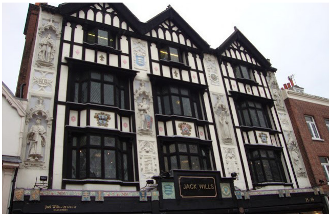
Abb.3: Die Tudor-Fassade des Gebäudes Market Place Nr. 16 in Kingston upon Thames. © Copyright Philip Halling (www.geograph.org.uk)
