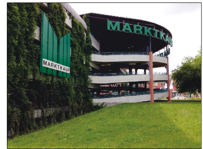
Inzwischen zugewuchertes Parkhaus
