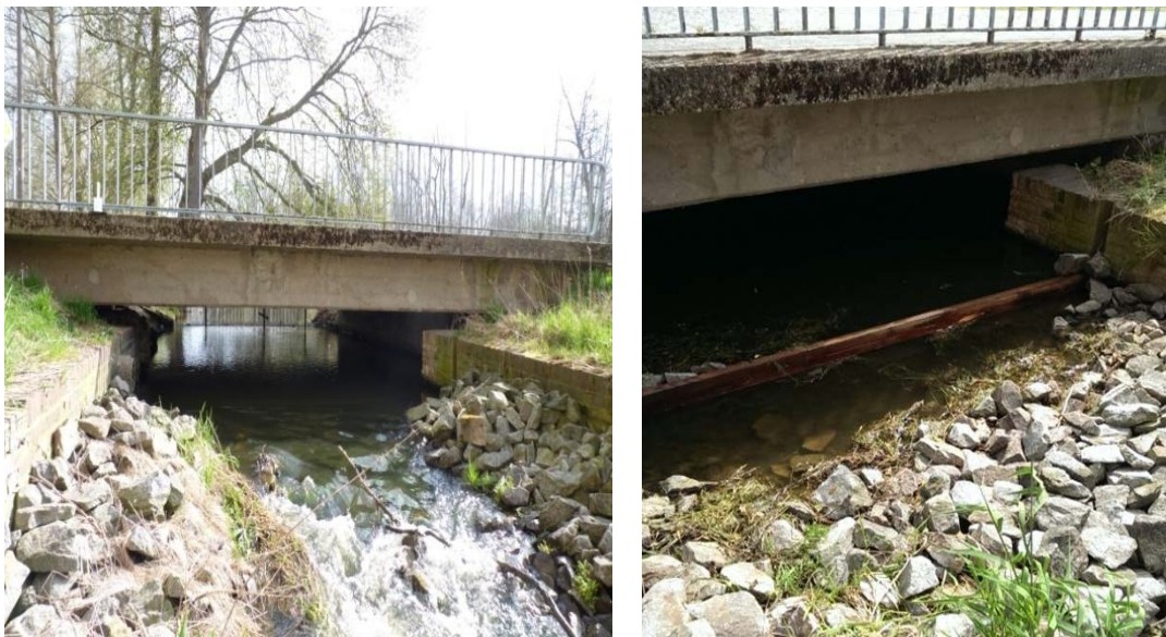
Abb. 6 und 7: links: Messstelle STAA am Ablauf des Stahnsdorfer Sees vor der Erhöhung der Schwelle; rechts: Erhöhung der Sohlschwelle zum Anstauen des Stahnsdorfer Sees ab dem 28.05.2015.
