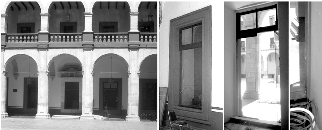
Abbildung 63: Neue Fenster in einem Universitätsbau
