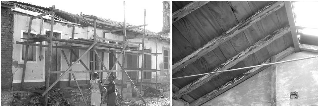
Abbildung 40: Baustelle Santa Ana
