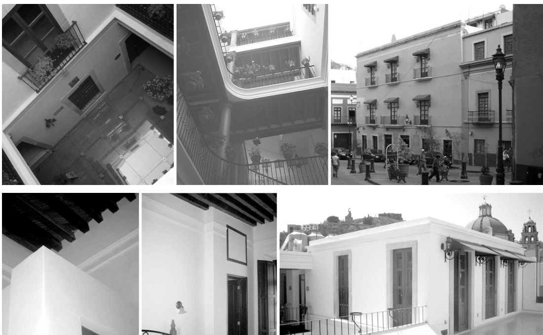
Abbildung 60: Hotel Azul (Patio, Zimmerteilungen und Dachaufbau)
