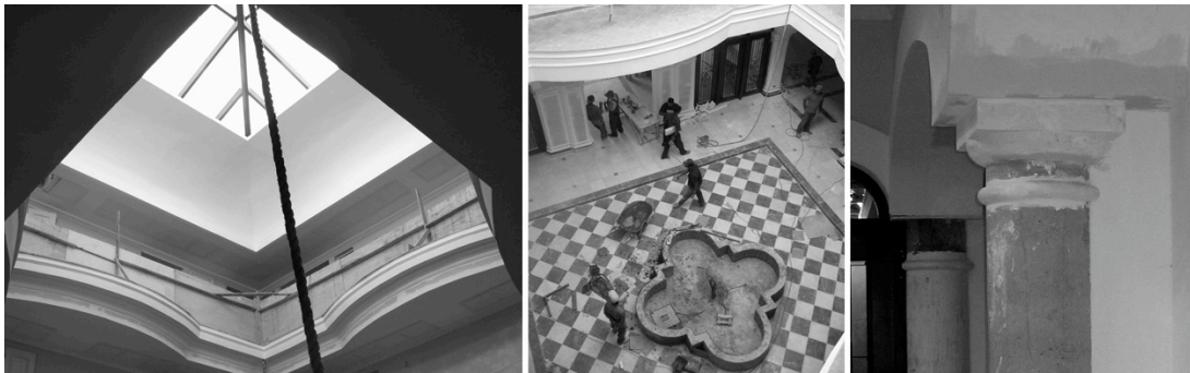
Patio: Glaspyramide, Brunnen, Stahlbetonstützen mit Gipskapitel
