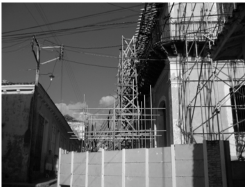
Abbildung 32: Ruine Palacio Iznago
