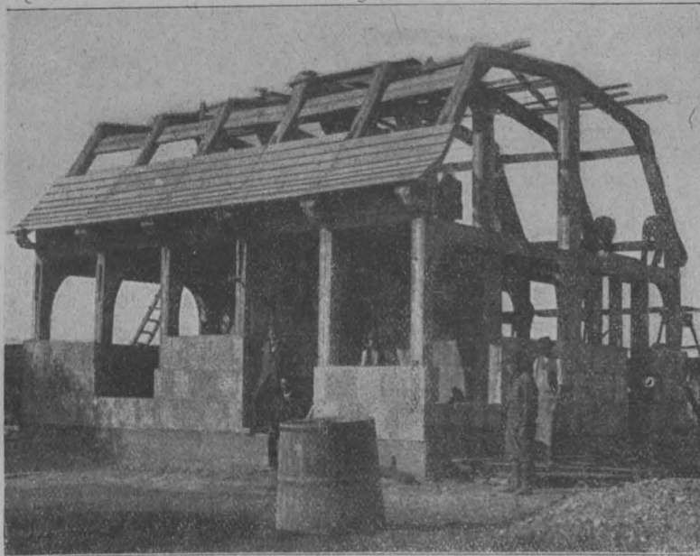
Abb. 2. Arbeiterwohnhaus im Bau in Straßhof.
