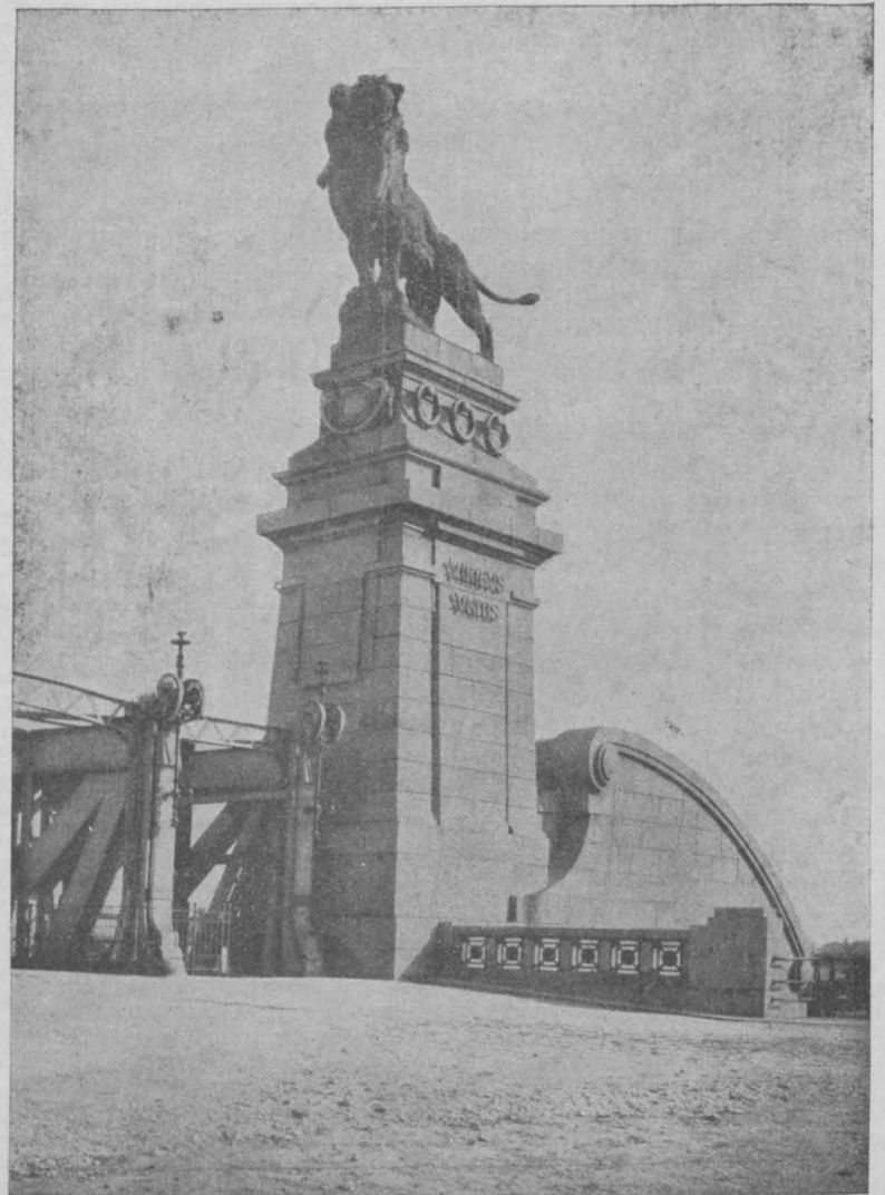
Abb. 3. Widerlager des Nadelwehres Nußdorf.
