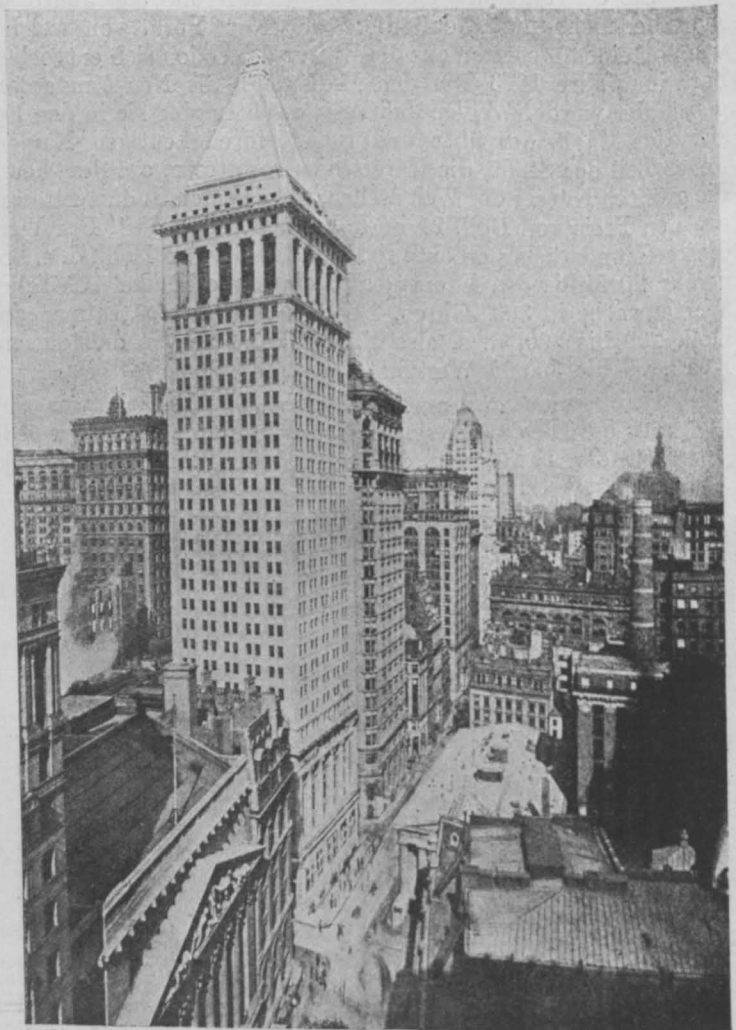
Abb. 13. Das Gebäude von Bankers' Trust Co. in New York.
