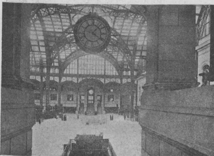
Abb. 9. Inneres des Bahnhofes der Pennsylvania-Bahn in New York.
