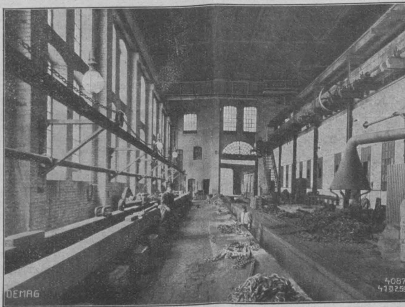
Abb. 2. Kettenprüfraum der Deutschen Maschinenfabrik A.-G., Duisburg.
