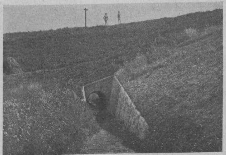
Abb. 22. Vizinalbahn Marosludas - Besztercze, Wasserscheide Budatelke. Prof. 91/92. 2 m-Objekt am Nullpunkte.
