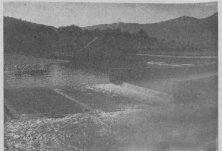
Abb. 20. Bau der Floßfeder im Jänner 1911. Ansicht der fertiggestellten Floßfeder mit Puffer.
