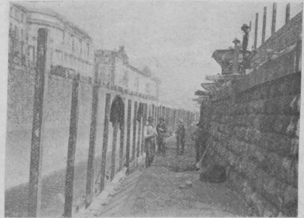
Abb. 6. Ergänzung des rechten Widerlagers.
