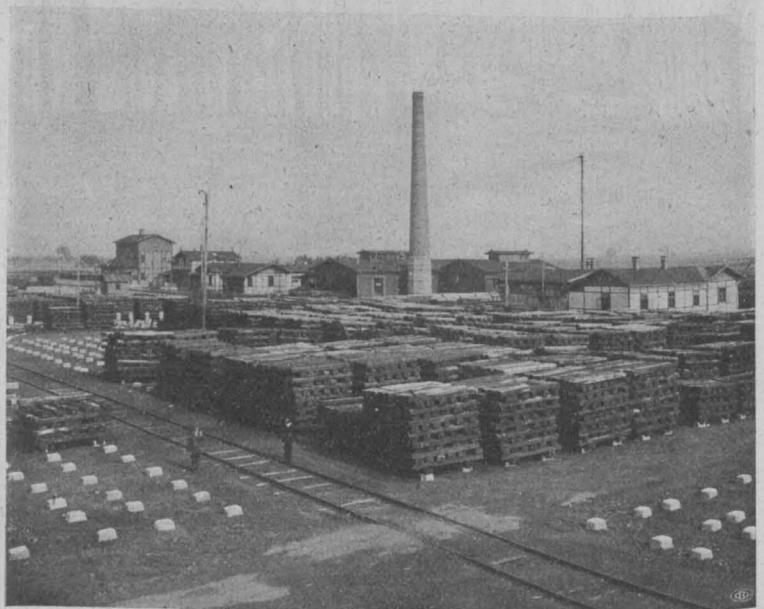
Abb. 39. Lager von imprägnierten Schwellen (Kreuzstöße). Imprägnieranstalt Zadwórze, Galizien, der Komm.-Ges. Guido Rütgers, Wien.
