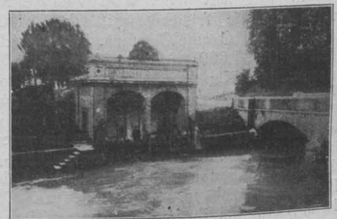
Abb. 2. Schützenhaus an der Abzweigung des Kanales „Quintino Sella“.
