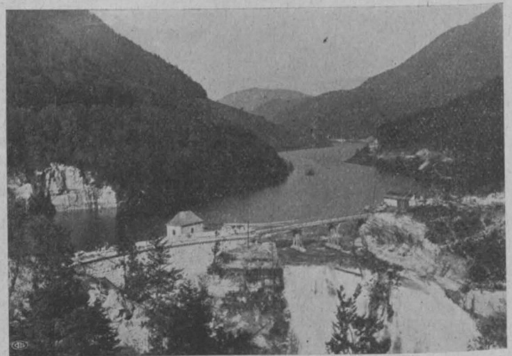
Abb. 4. Ansicht der Staumauer und des Stausees.
