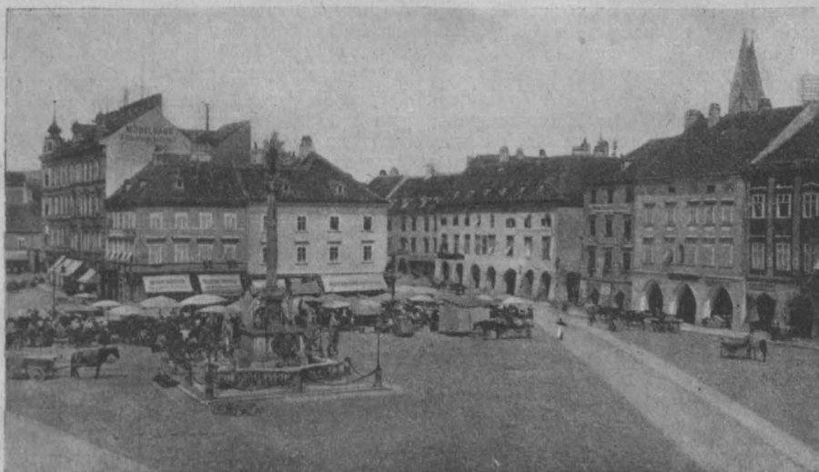
Abb. 2. Wiener-Neustadt, Stadtplatz (die mittlere Baugruppe verunstaltet).
