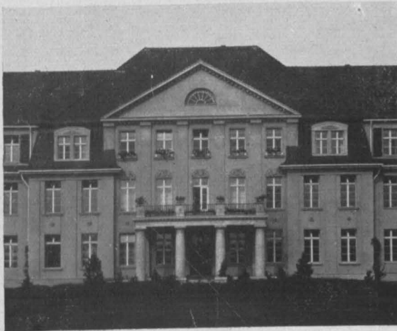
Städt. Krankenhaus, Vorfahrt, Ostseite
