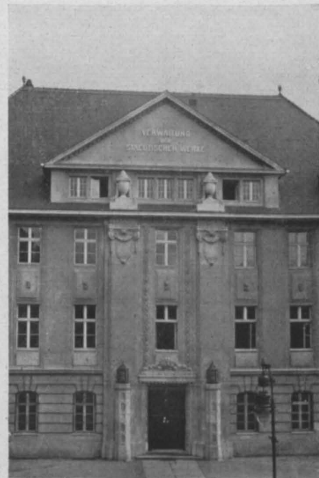
Verwaltungsgebäude der Städt. Werke Mittelpartie der Straßensicht
