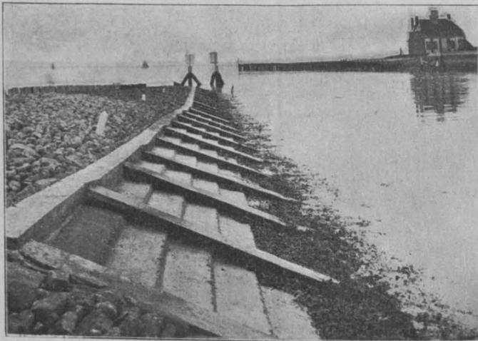
Abb. 14 Betonböschung, die täglich ganz vom Wasser bespült wird
