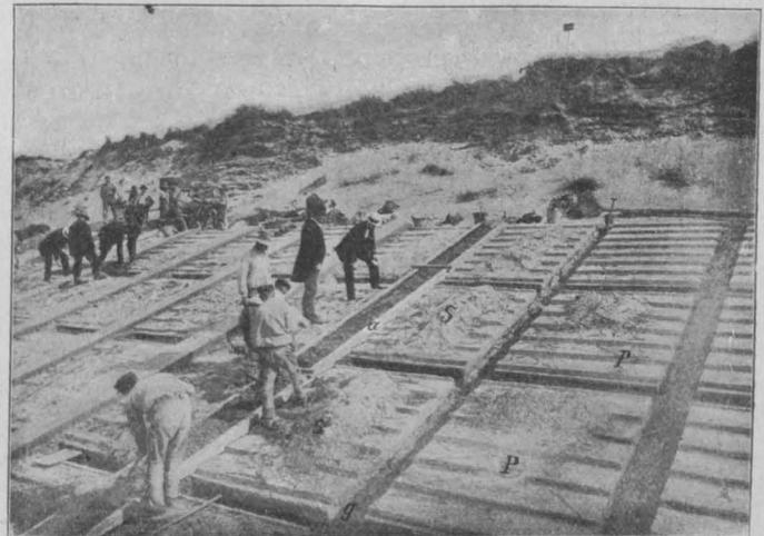
Abb. 9 Gräben und Formen zum Einstampfen der Vertikalbalken
