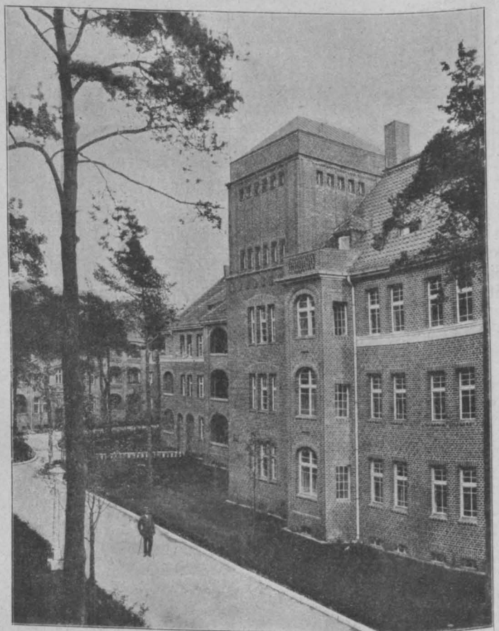
Abb. 22 Baugruppe Niederschönhausen (Hofstraße)
