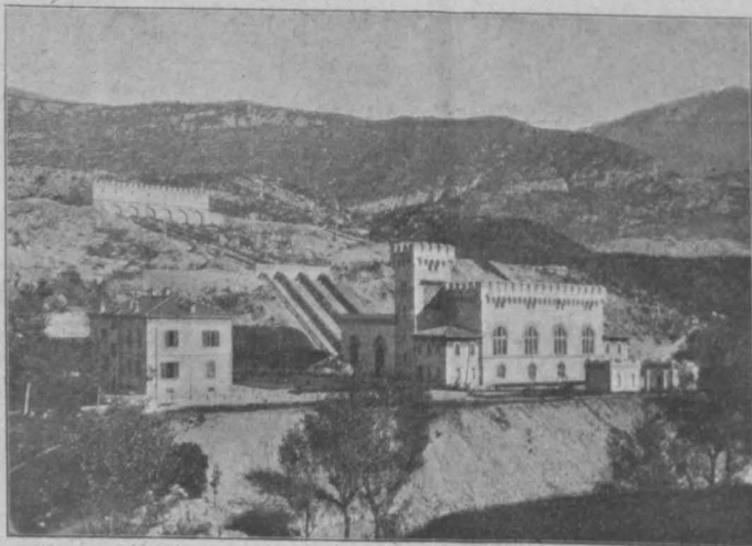
Abb. 53 Elektrizitätswerk an der Sarca, Wasserschloß, Druckrohrleitungen und Kraftwerk
