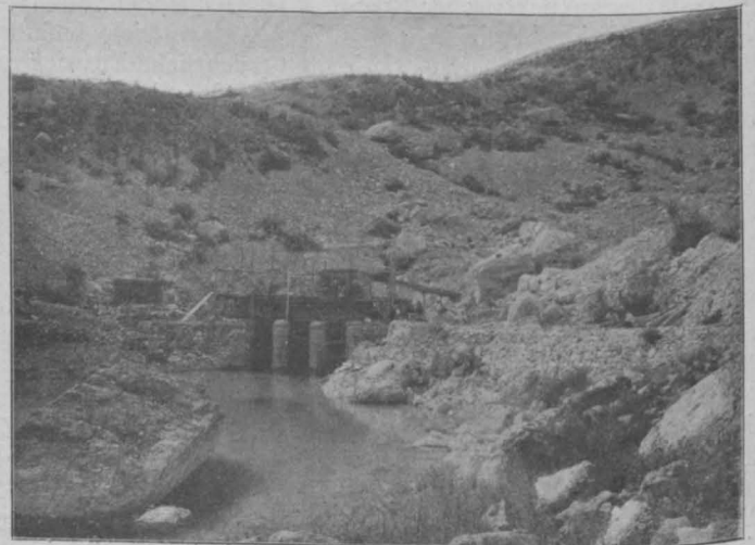
Abb. 48 Fassungsobjekt beim Stollenanfang im Laghisol
