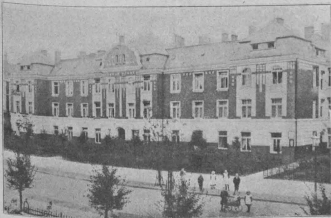
Abb. 16 Arbeiter-Spar- und Bauverein Altona
