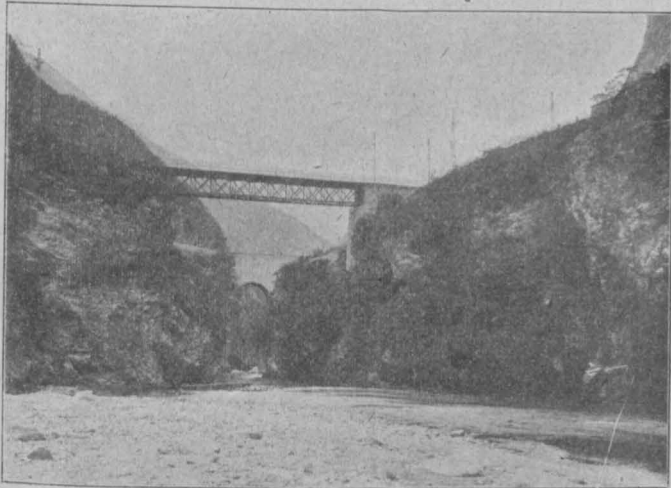
Abb. 6 Nocebrücke bei Rocchetta, Hochspannungs-Fernleitung
