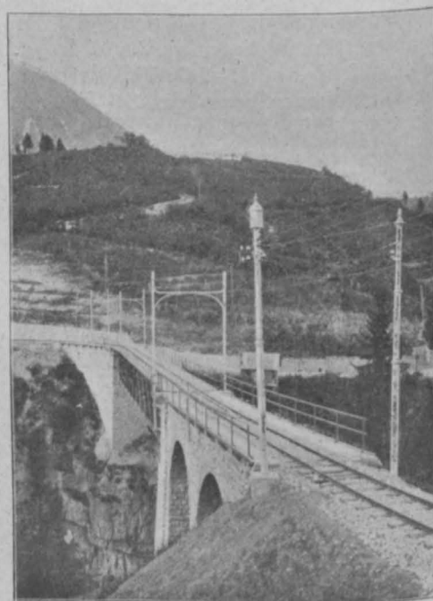
Abb. 20 Fahrleitung an eisernem Gestänge (Mostizzolo-Brücke), Kabelüberführungsmast
