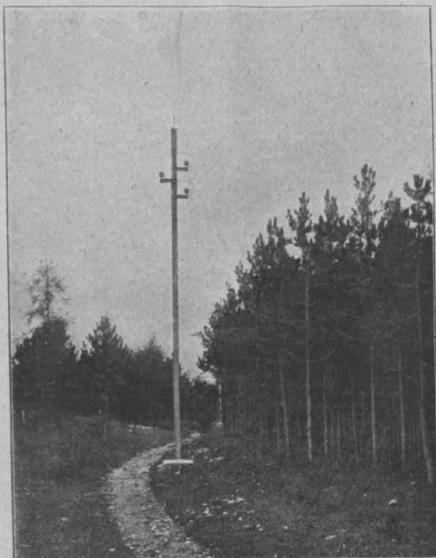
Abb. 41 Doppel-T-Mast mit Fangbügeln
