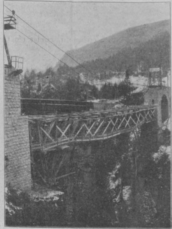
Abb. 12 Mostizzolobücke, Montagegerüst
